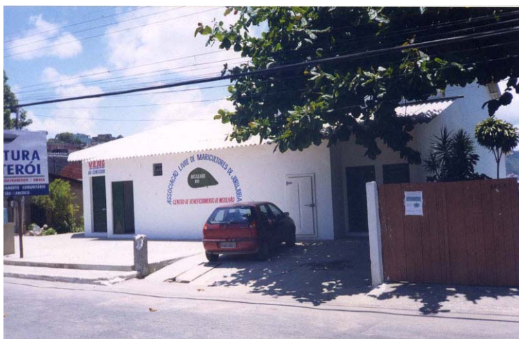
Figura 13 – Prédio do Centro de Beneficiamento após o término da obra. Imagem cedida por Marcos Bezerra de Menezes.
