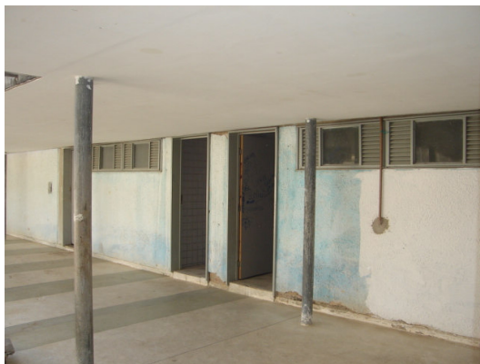
Foto 5.13 – Médici - Acesso aos wc's
