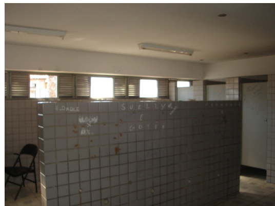
Foto 5.14 – Médici - Iluminação wc
