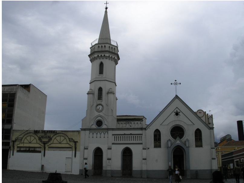
Figura 3.4.1.a: Igreja da Ordem III de São Francisco das Chagas – exterior do edifício.
