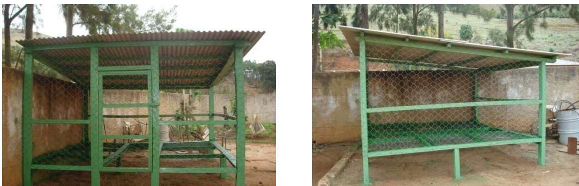
Figura 19: Local para armazenamento de materiais recicláveis (ainda sem placa de identificação) – E. M Alfredo Brandão - APA Alto Taboão
