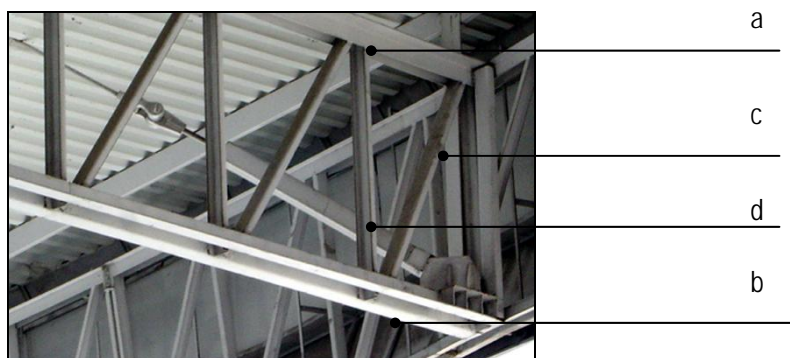
Imagem 150. Detalhe de uma viga treliçada da cobertura metálica.
