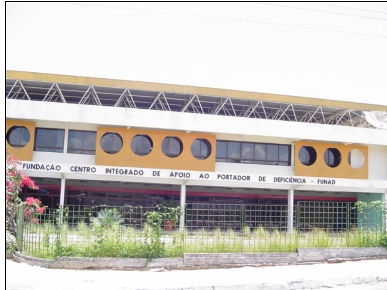
Imagem 165. Vista Parcial, Fachada de acesso principal.
