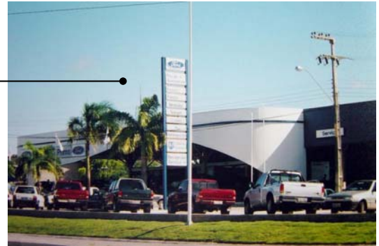
Aspecto geral da edificação.
