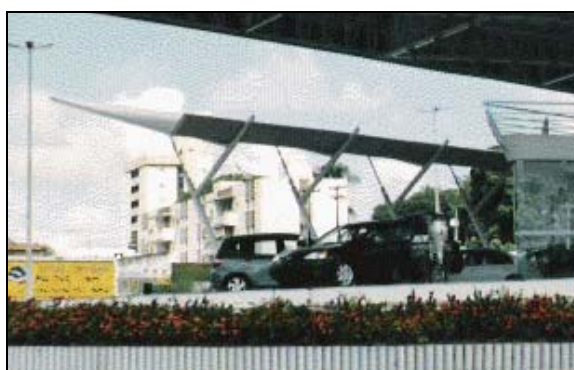
Imagem 154. Peça longilínea para auxílio na proteção solar.
