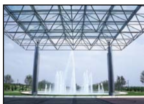
Estrutura de malha tipo MERO. Edifício da Samsung, Texas, EUA. ( www.MERO.un )
