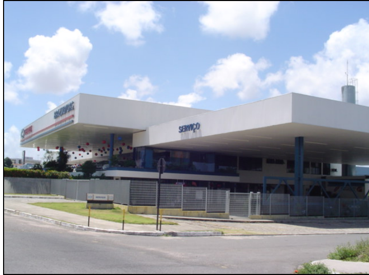
Imagem 112. Vista geral da fachada de acesso principal
