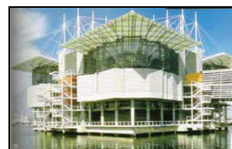
Estrutura estaiada. Pavilhão dos Oceanos, Expo 98 – Lisboa. (PROJETO, 223, 98:57)
