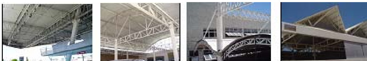
Imagem 203. Coberturas com arranjos treliçados de Vetor Ativo, conjugadas a sistemas de cabos ou de Forma Ativa.
