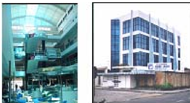
Imagem 205. Edificações de quatro pavimentos: MAG Shopping e Moby Dick.
