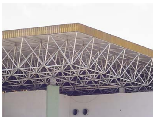
Imagem 168. Detalhe do topo reforçado de um dos pilares externos de suporte da cobertura espacial.
