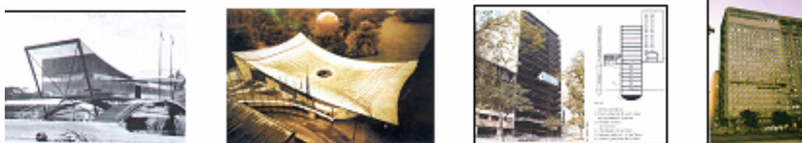
Imagem 1. As primeiras obras com estrutura em aço realizadas por arquitetos brasileiros.
