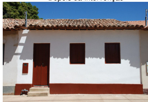
Depois da Intervenção
