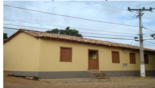
Depois da Intervenção
