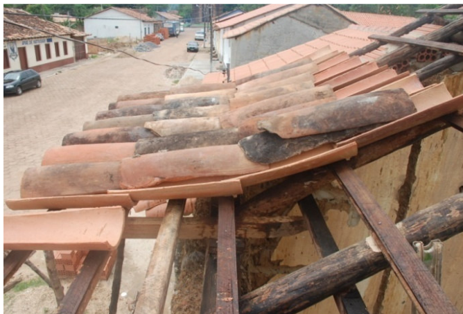
Figura 20 – Cobertura com telha antiga como capa e a nova como canal.
