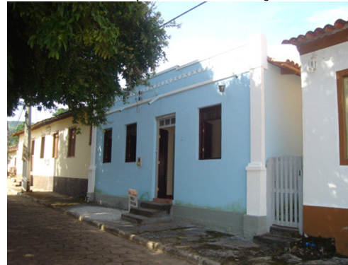
Depois da Intervenção
