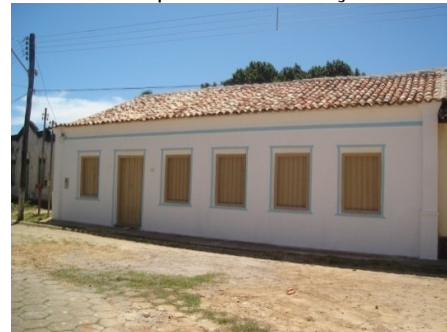
Depois da Intervenção
