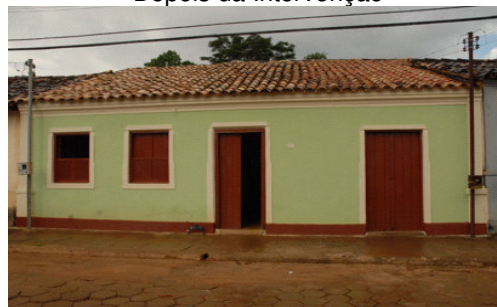
Depois da Intervenção
