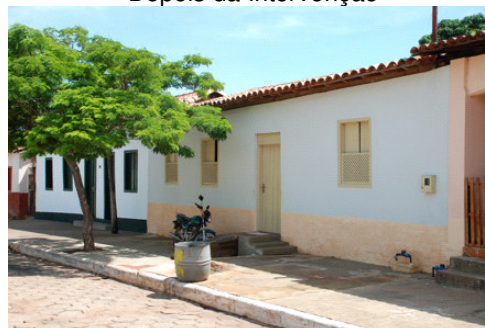
Depois da Intervenção
