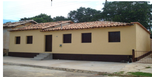
Depois da Intervenção
