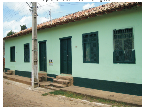
Depois da Intervenção
