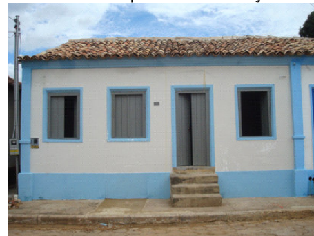
Depois da Intervenção
