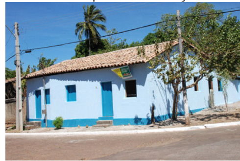
Depois da Intervenção
