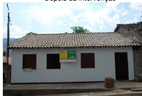
Depois da Intervenção
