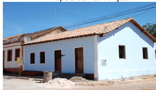
Depois da Intervenção
