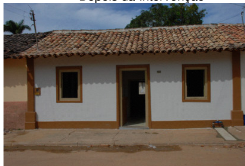
Depois da Intervenção
