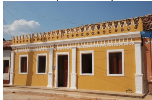
Depois da Intervenção
