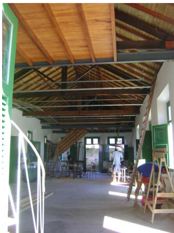
Imagens nº45 e 46 – Vista externa e interna da “Casa de Máquinas”, em reforma para abrigar o espaço não-italiano de teatro, atrás do Centro Cultural Bento Silvério (autoria do pesquisador), em 2009.
