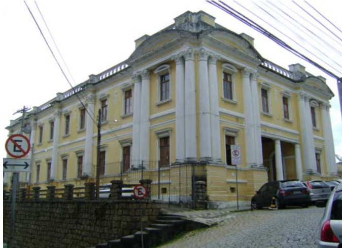
Imagem nº84 – Vista do antigo prédio que sediou a Escola Normal Catharinense e da FAED, no centro de Florianópolis, sede atual do Museu da Escola Catarinense da UDESC, em 2009 (autoria do pesquisador).
