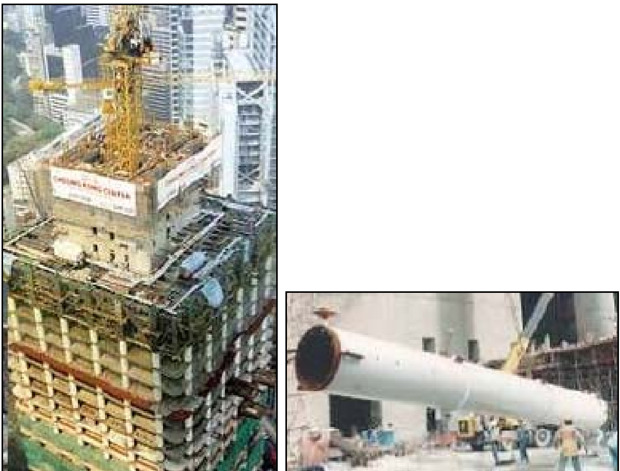
Figura 2.8 - Edifício Cheung Kong Center (Hong Kong, 1999) com altura total de 289 metros e 63 pavimentos. Fonte: http://www.emporis.com/en/bu/
