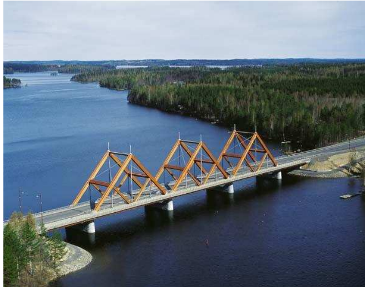
Figura 2.10 – Ponte Vihantasalmi, Finlândia. Fonte: MESTRA Engineering Ltd. (2005)
