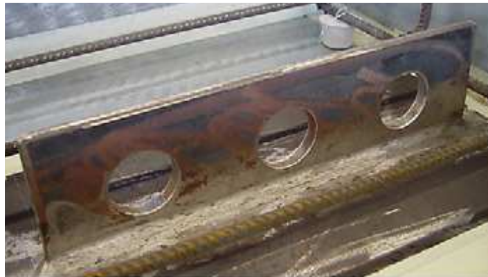
Figura 2.16 – Conector tipo perfobond . Fonte: Valente e Cruz (2004)
