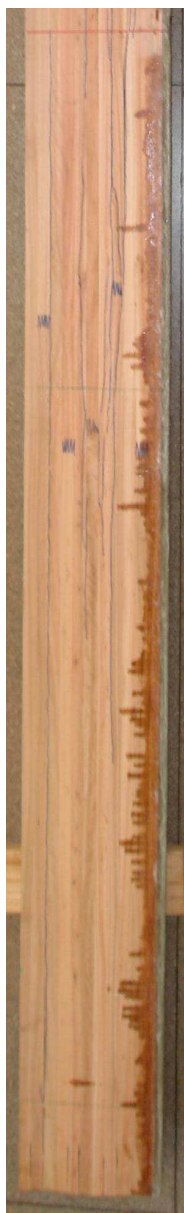
Figura G.4(a) – Ruptura da viga V5: lado esquerdo
