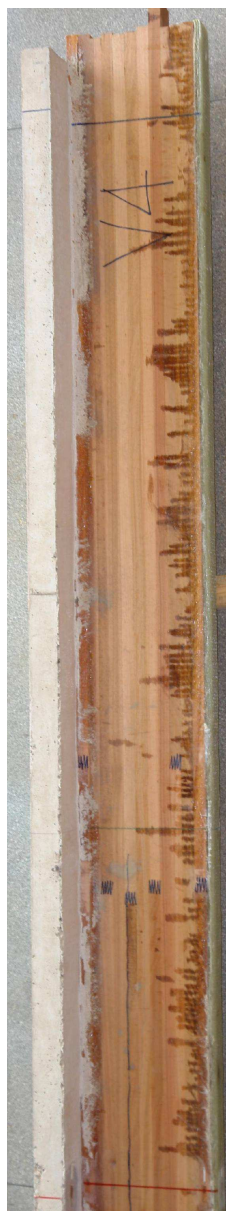
Figura G.7(b) – Ruptura da viga V4: lado direito
