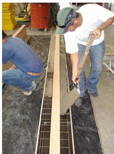
Figura 5.25 – Concretagem das vigas mistas
