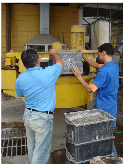
Figura 3.7 – Preparação do concreto para os corpos-de-prova de cisalhamento
