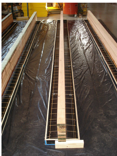
Figura 5.24 – Fôrmas das vigas mistas
