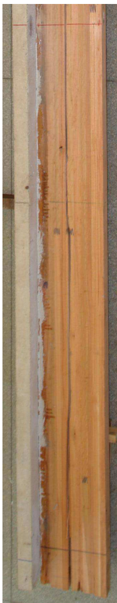
Figura G.5(a) – Ruptura da viga V1: lado esquerdo
