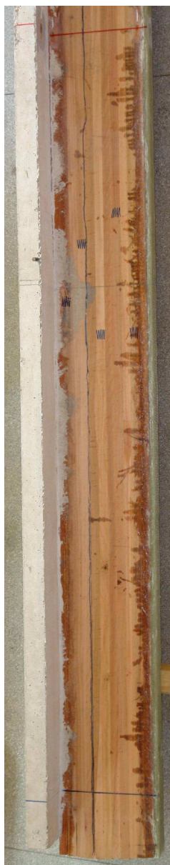
Figura G.7(a) – Ruptura da viga V4: lado esquerdo
