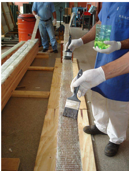
Figura 5.8 – Aplicação do adesivo epóxi
