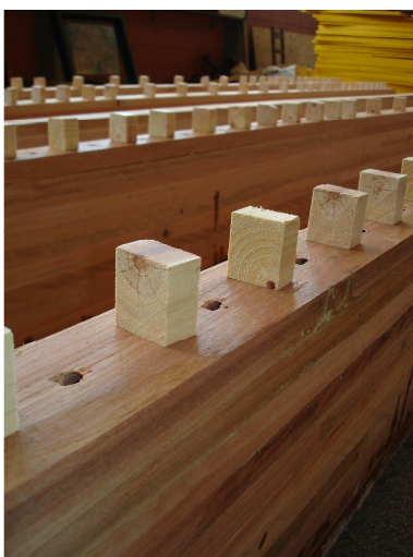
Figura 5.21 – Suportes auxiliares na fixação dos ganchos metálicos
