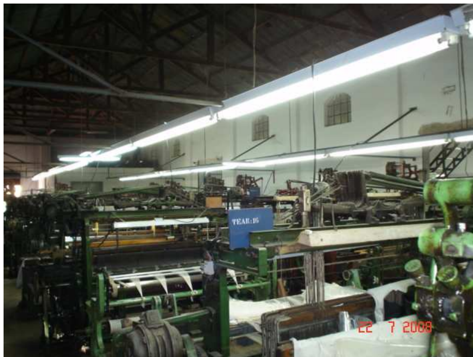
Figura 27 - Iluminação geral e localização dos teares.
