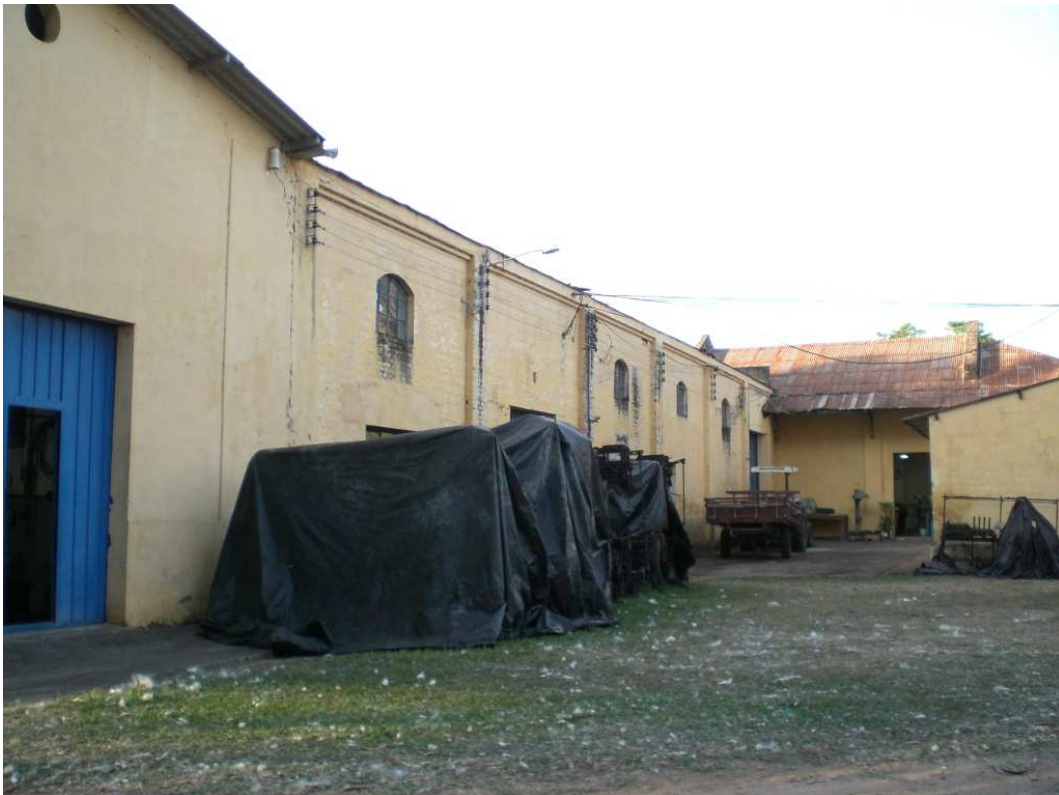
Figura 25 – fachada, mostrando parte antiga, com ampliação.
