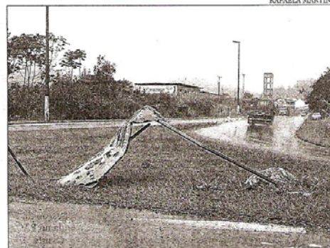
Ela não resistiu. A placa colocada perto do trevo do Ceileiro do Vale, na entrada de Blumenau, não sinaliza mais nada
