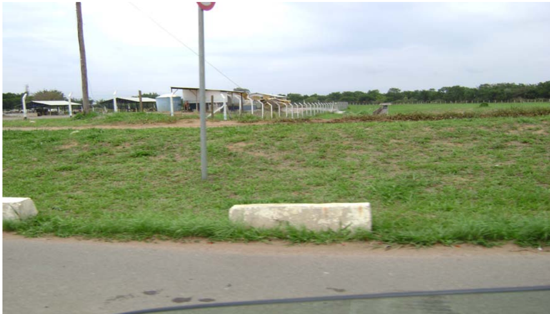
FIGURA 28 - O abandono do canteiro de obras.
