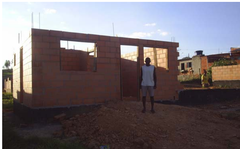
Figura 32: Foto da moradia em ponto de laje, que esta sendo construída no Jardim das Orquídeas.
