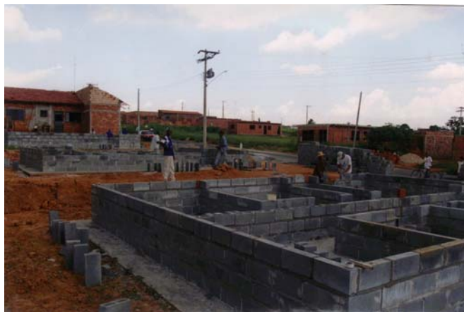
Figura 23: Construção da 1ª etapa das casas no Jd. Das Orquídeas
