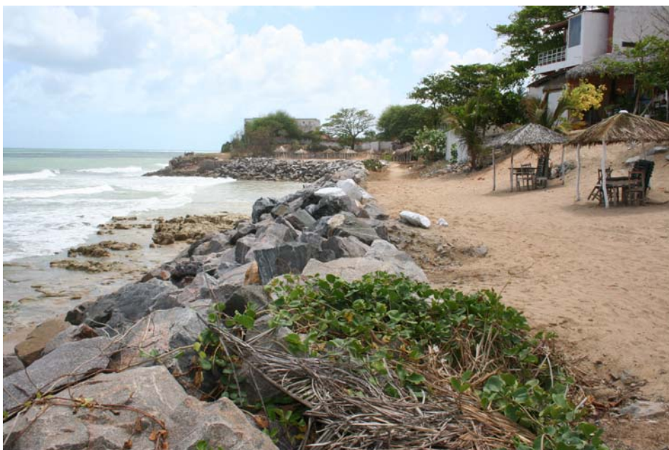
Figura 44 – Estruturas de proteção de costa na praia de Iparana.
