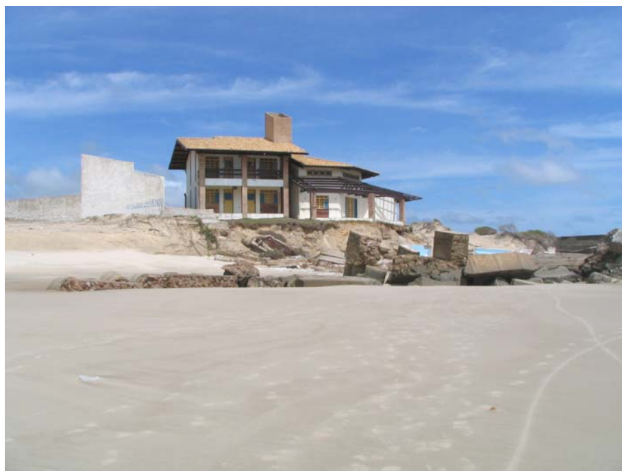
Figura 32 – Casa destruída pela ação da erosão costeira.
