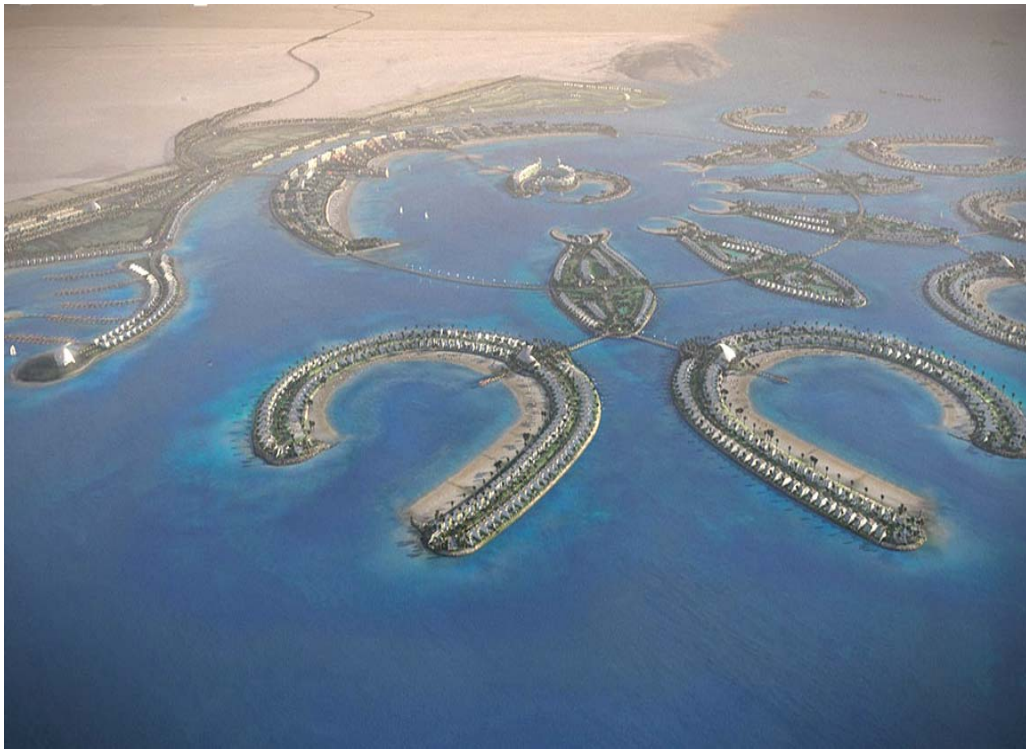
Figura 63 – Exemplo de engorda artificial para execução de projeto de condomínio de luxo em Dubai – Emirados Árabes.
