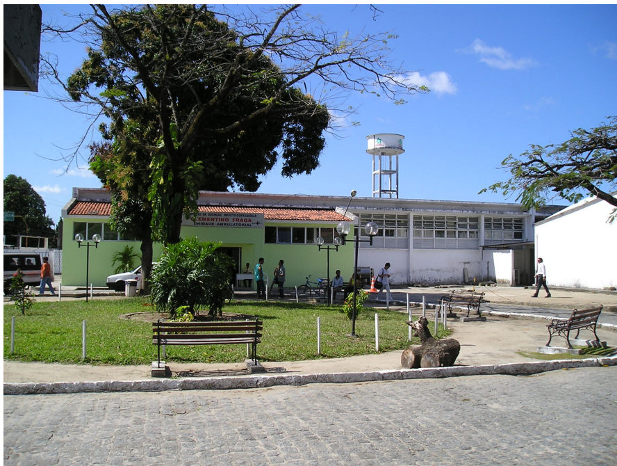
B11: Fachada Sul do edifício – entrada para o ambulatório
