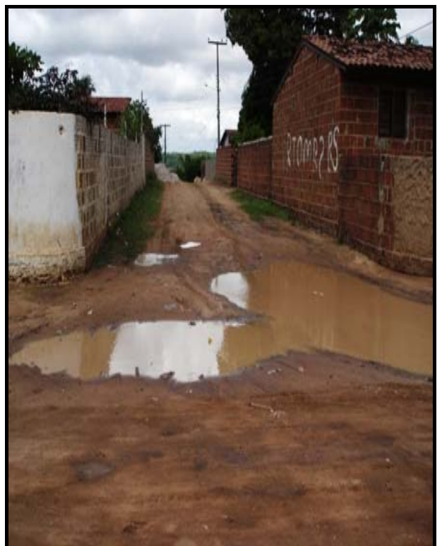
Figura B. 16 – Rua empoçada após a chuva (Gramame)
