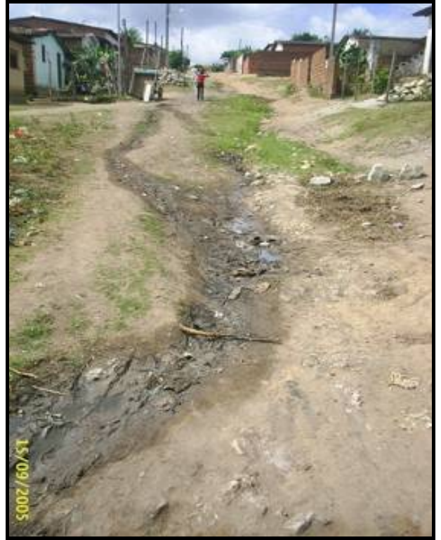
Figura B.6 – Lançamento de águas residuárias nos logradouros (Colinas do Sul)
