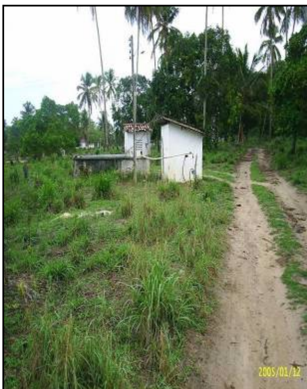
Figura B.3 – Captação de água para abastecimento individual (Mituauçu)
