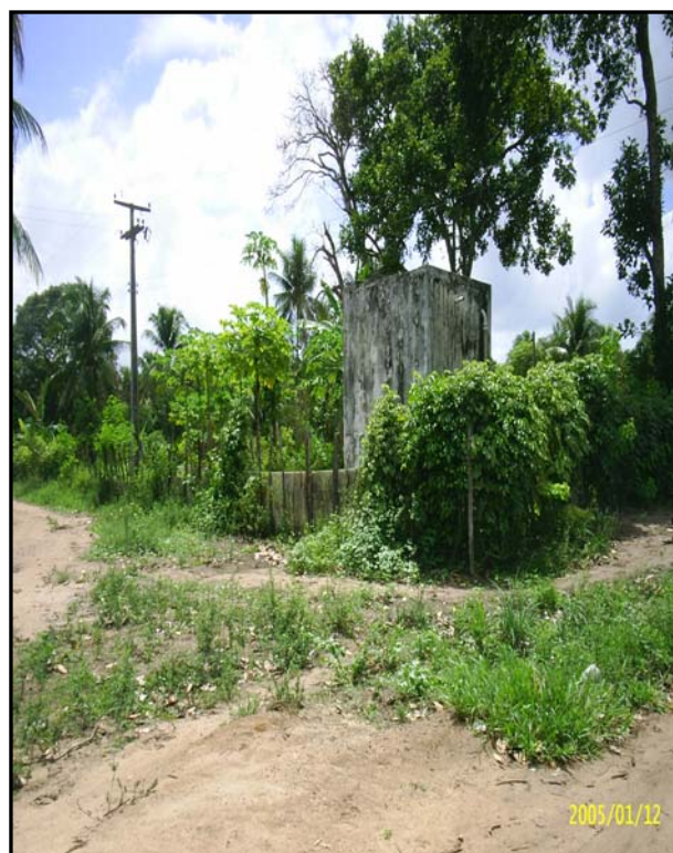
Figura B.4 – Reservação de água para o abastecimento coletivo (Engenho Velho)
