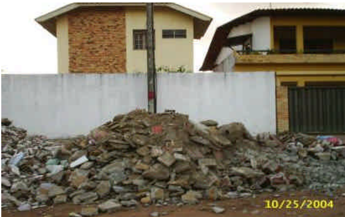
Figura 2.3 - Construção no Bairro do Bessa.
