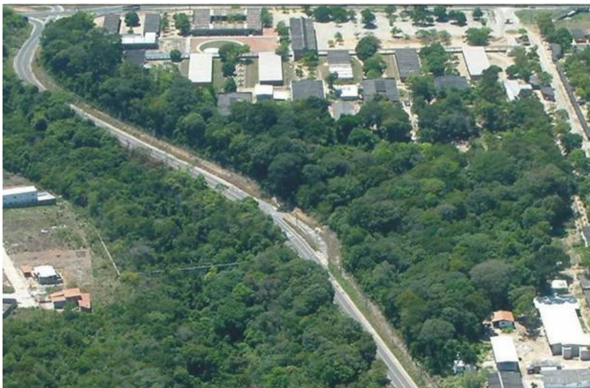
Figura - 4.2 Foto aérea do Centro de Tecnologia
