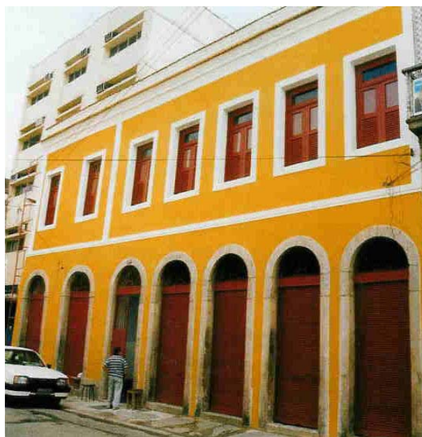
Figura 38 – Imóvel na Rua Senador Pompeu, 34. Antes da reforma de 1996, na esquerda e depois em 2003 na direita. Fonte: RIO DE JANEIRO, 2003.
