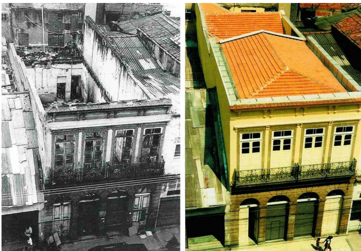
Figura 31 – Imóvel na Rua Sacadura Cabral, 295 depois da reforma. Fonte: RIO DE JANEIRO, 2003.
