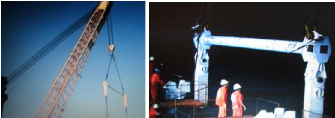
Figura 1.2b – Instalação do manifold do Campo de Albacora via BGL-1 com eslinga de içamento.
