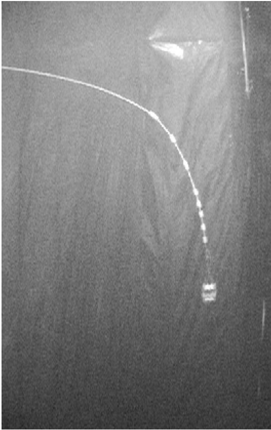
Figura C.17 – Imagem da câmera C3 e câmera C2 do lançamento pendular do manifold MSGL-RO-01 (REF. MSGL-C10-D12-LI1-H2-F1).
