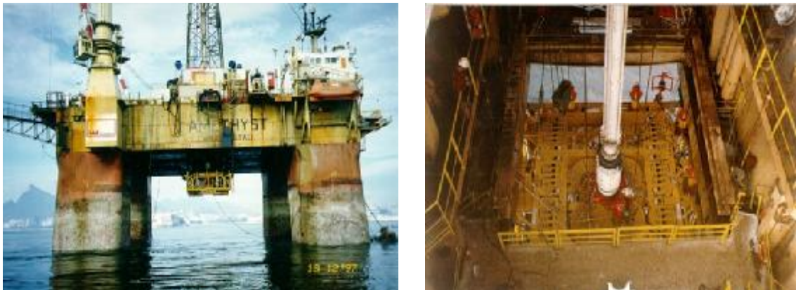
Figura 1.2c – Instalação do manifold de produção via riser de perfuração no Campo de Marlim.
