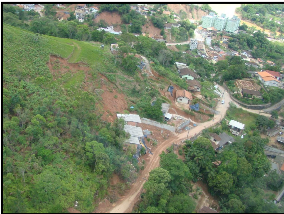
Figura 15 – Exemplo de escorregamento translacional (Blumenau, Santa Catarina).
