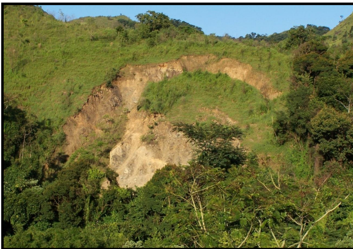
Figura 13 – Exemplo de deslizamento rotacional (Blumenau, Santa Catarina).
