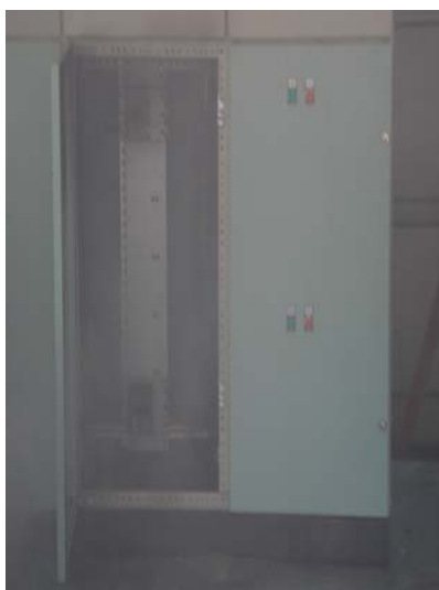
Figura 52 - Atuação prolongada de Water Mist Fonte: Acervo do autor
