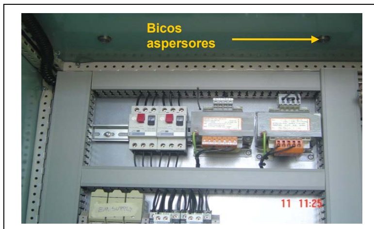
Figura 42 - Internos do painel e bicos aspersores Fonte: Acervo do autor
