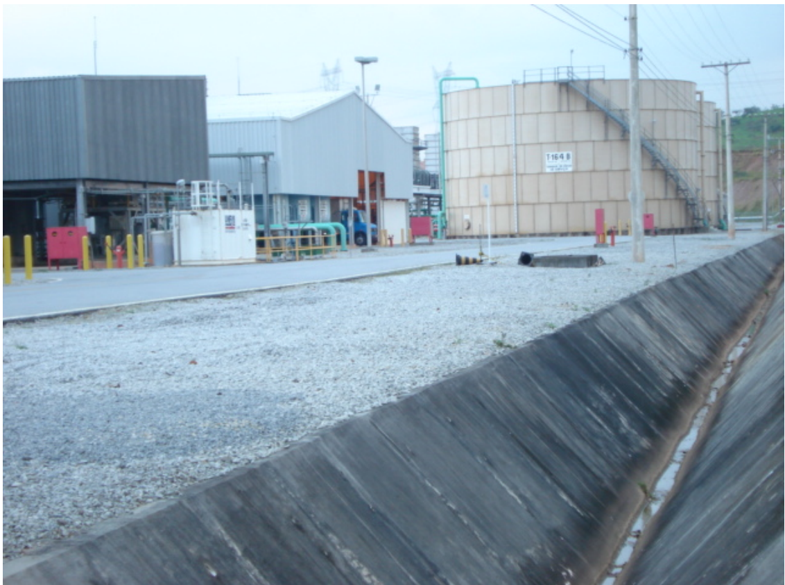
Figura 03 - Estação de Tratamento de Água da UTE Mário Lago Fonte: MATOS (2008)
