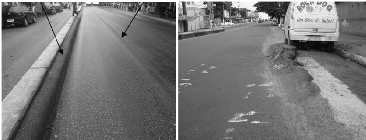
Figura 1.1-1: Exemplos de deformação plástica em trilha de roda e escorregamento do revestimento em Manaus
