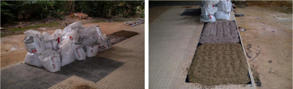
Figura 9 – Ensacamento do seixo e areia; Figura 10 – Secagem do seixo e areia (Fotos do autor: Laboratório de Pavimentação da UFAM, 2007).
