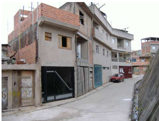
Foto 63 – Travessa rua 2 – residências (da esq. Para a direita) –
