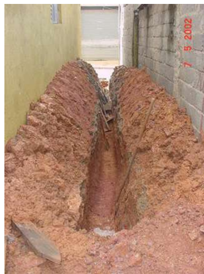
Foto 100 – rede de esgoto – viela 27
