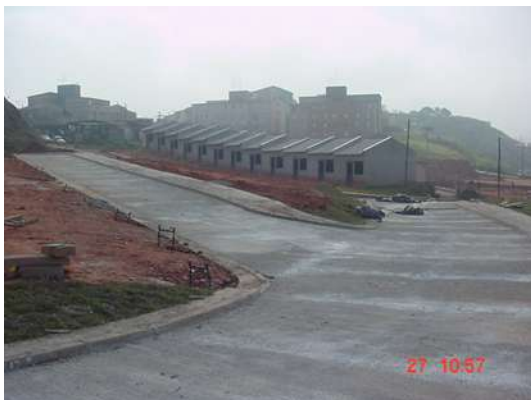
Foto 18 – rua com pavimento rígido – local.
