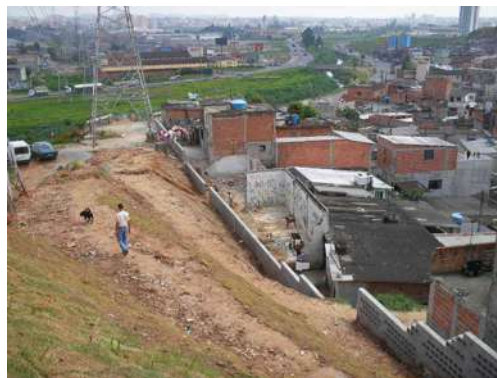
Foto 134 – muro, vielas e autoconstrução transmissão da Eletropaulo
