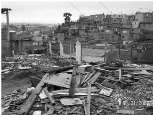
Foto 145 – demolições - rotatória da rua 5
