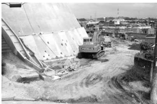
Foto 64 – contenção em solo grampeado – setor 1 Fonte: L. Felipe / DEHAB/ SDUH/ PSA; ago/ 2002
