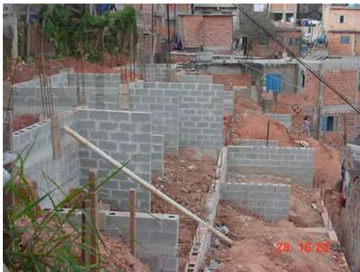
Foto 52 - Contenção de encostas setor 1; Fonte: L. Felipe / DEHAB/ SDUH/ PSA; jul/2003
