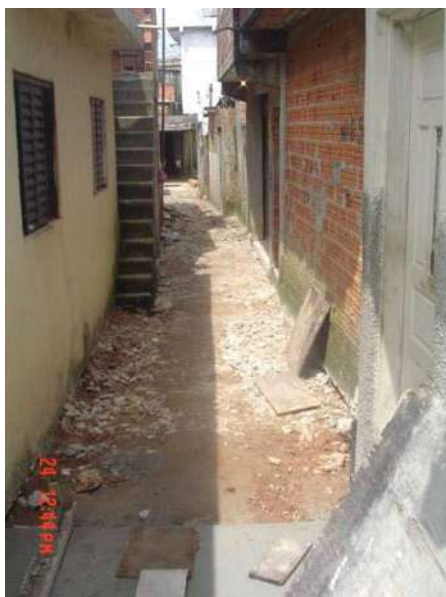
Foto 101 – escada de acesso/ demolição (viela 24)
