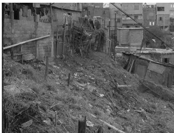
Foto 52 - (antes) setor 1- deslizamento Fonte: L. Felipe / DEHAB/ SDUH/ PSA; ago/2002.
