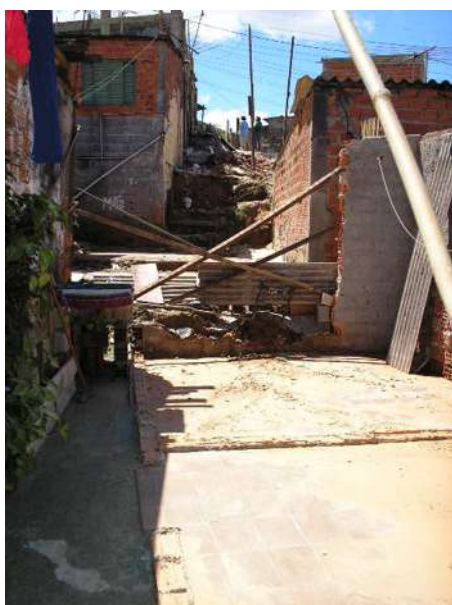
Foto 155 – viela sanitária - demolições
