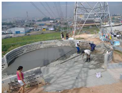
Foto 136 – concretagem via 145 (rotatória) linha de transmissão da Eletropaulo
