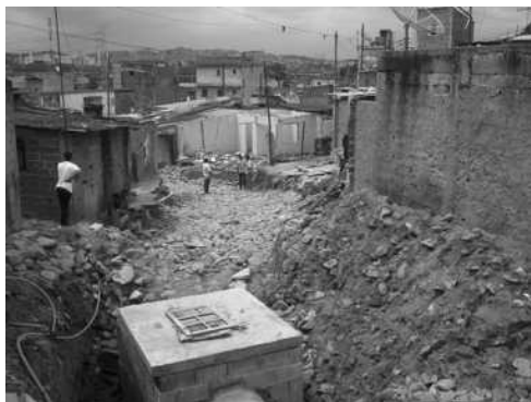
Foto 120 – demolição/ preparo de caixa – rua 6 Fonte: L.Felipe / DEHAB/ SDUH/ PSA; jan/ 2005
