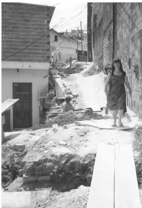
Foto 107 – execução de contenção - rua 5
