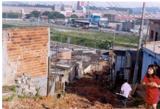
Foto 8 – abertura da rua São Paulo
