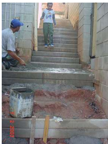
Foto 48 - Execução de escada (durante) viela 40;
