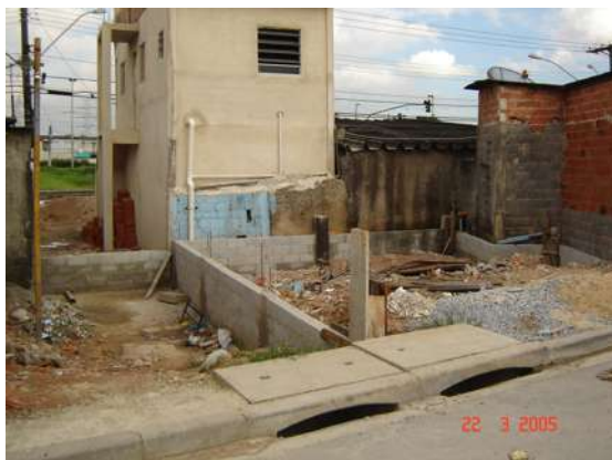
Foto 76 – viela sanitária/ interligação da drenagem da rua 7
