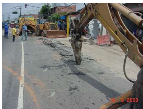
Foto 68 – interdição parcial da Av. dos Estados Foto 69 – perfuração para escavação de rede
