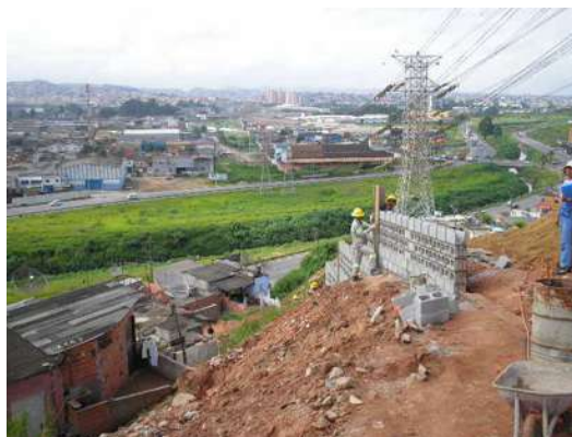
Foto 138 – limpeza/ execução de muro transmissão da Eletropaulo
