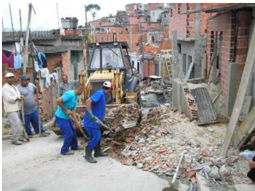
Foto 168 – remoção de entulho -rua 6
