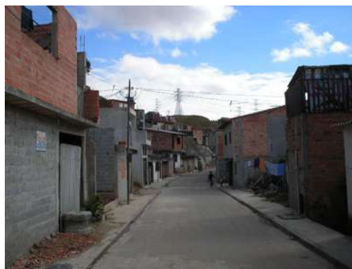
Foto 73 – auto construção – rua 7
