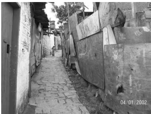
Foto 151 – futura rua 5 (antes)
