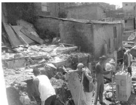
Foto 159 demolição cad. 160 e 172
