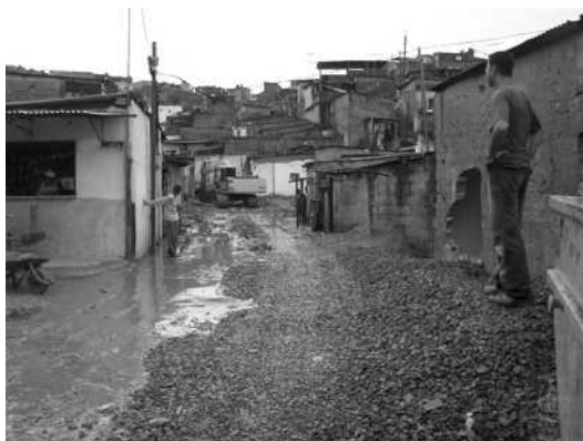
Foto 166 – demolição e abertura da Rua 6
