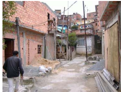
Foto 117 – prolongamento da rua 6 (durante)
