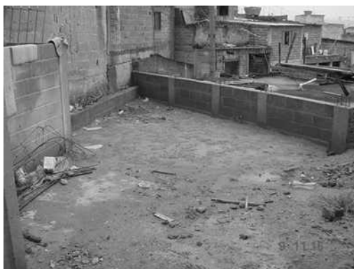
Foto 57 – contenção no fim da rua Proust
