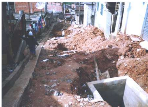
Foto 9 – rede de drenagem da rua São Paulo
