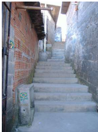
Foto 154 – redes de infraestrutura – rua 6
