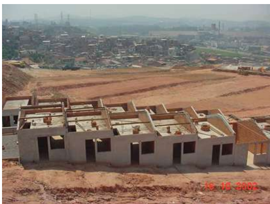
Foto 29 – alvenaria da cobertura/ barrilete
