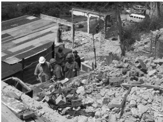
Foto 137 – demolições abaixo da linha de transmissão da Eletropaulo
