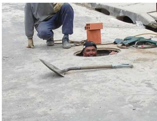
Foto 143 – desobstrução de rede de água pluvial
