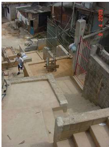
Foto 43 – viela 40/ escadaria (setor 1)
