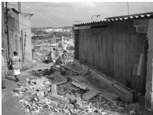
Foto 126 – demolição parcial - rua 5
