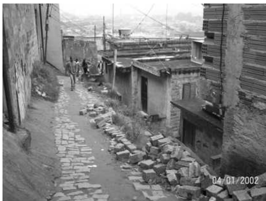
Foto 147 – futura rua 5 (antes)
