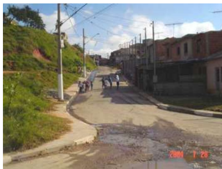
Foto 17 – Loteamento - rua G
