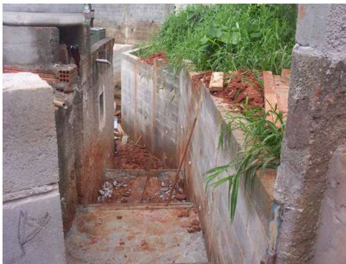
Foto 112 – escadaria/ contenção – viela 55
