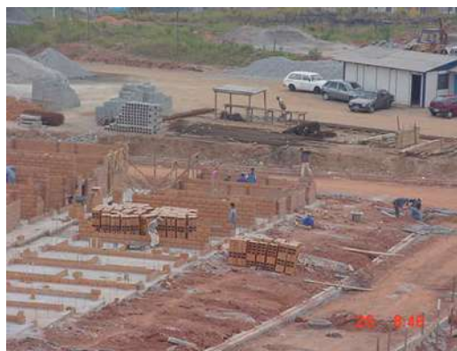
Foto 28 –alvenaria estrutural (2ª etapa);
