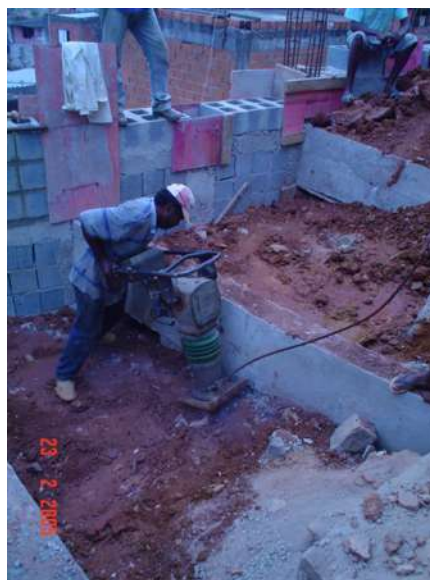
Foto 150 – compactação mecânica – rua 5
