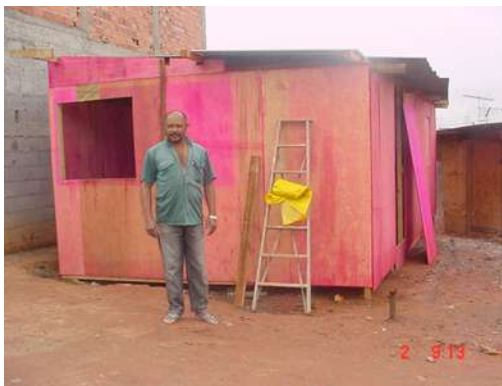
Foto 10 – morador “Chico de Pedro” – moradia provisória no lote parcelado
