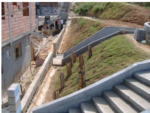
Foto 135 – residência/ mudas plantadas pelo Lídio – linha de transmissão da Eletropaulo
