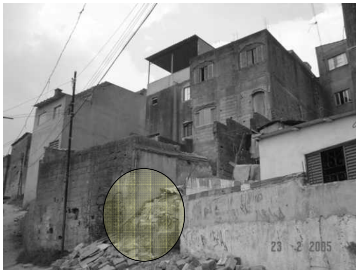
Foto 139 – demolição da “casa” da Luzia
