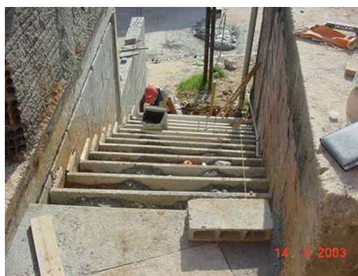
Foto 47 – colocação de espelhos pré-moldados
