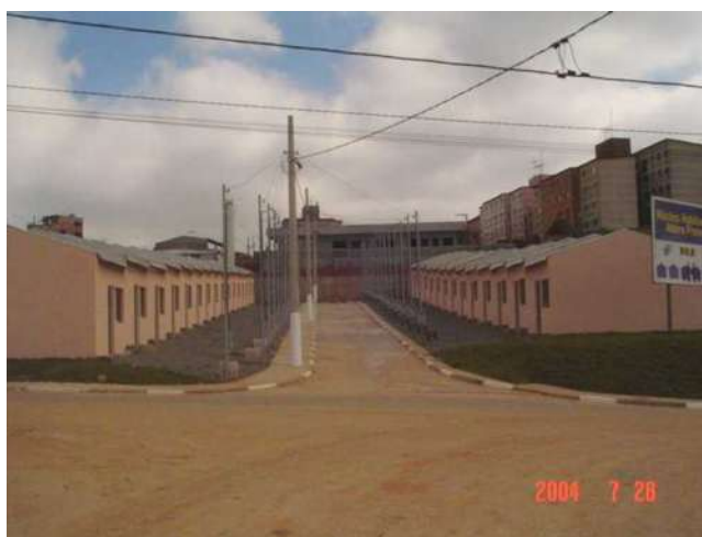
Foto 18 – Conjunto Alzira Franco I – Rede de Eletrificação da Rua C
