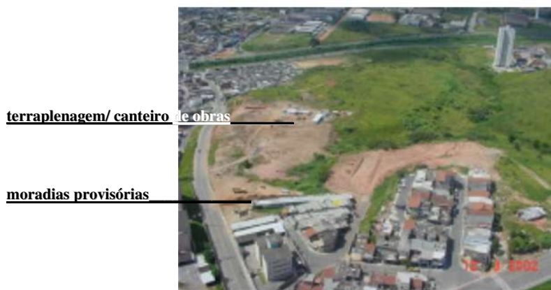
Foto 38 – moradias provisórias/ terraplenagem Conj. Alzira Franco I
