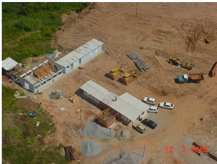
Foto 164 – canteiro de obra
