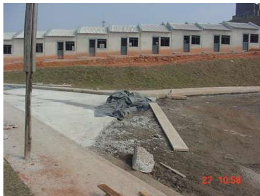
Foto 19 – rua local x Rua G (asfalto)
