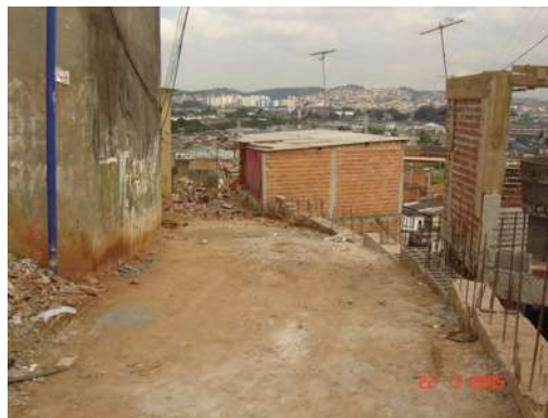
Foto 127 – compactação/ início – rua 5
