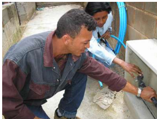
Foto 144 – abrigo de água na viela (Mestre de Obras Edson e Eng a Mônica)
