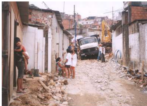
Foto 165 rua 6 – implantação de redes
