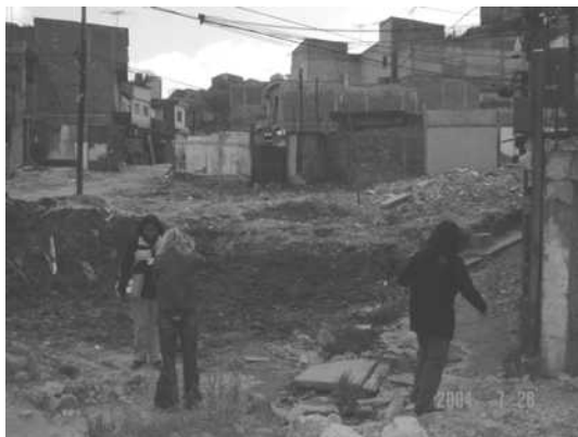
Foto 66 – abertura da rua 2 (antes)
