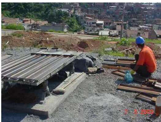
Foto 46 - mesa vibratória - usinagem em canteiro
