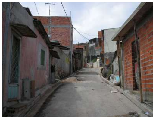
Foto 152 – autoconstrução – rua 5 (depois)
