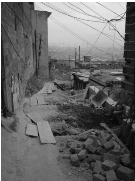
Foto 149 – execução de contenção - rua 5
