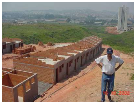
Foto 30 – alvenaria da cobertura/ barrilete
