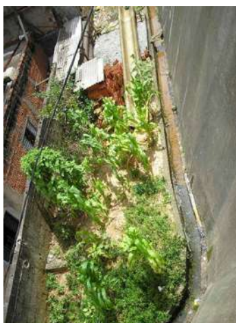
Foto 70 – fundo de lotes – “non edificandi” - rua 7
