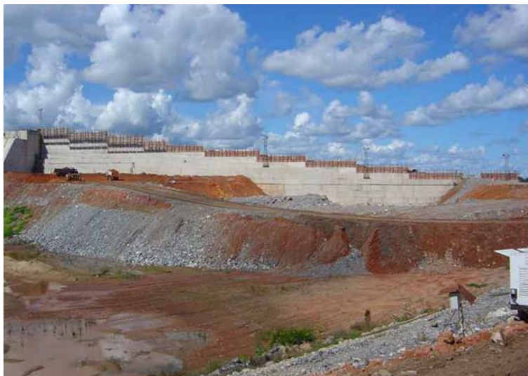
Figura 5 – Barragem em CCR no Leito do Rio (Arquivo FURNAS).
