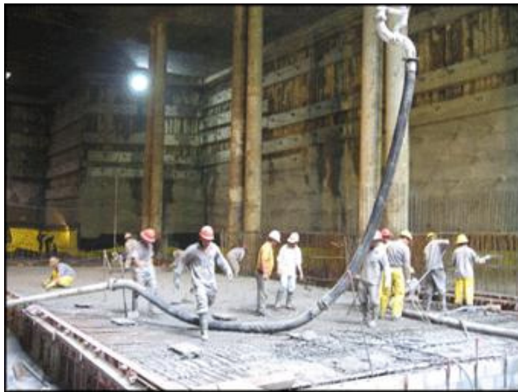
Figura 3: Concretagem do Bloco 3 da Estação Faria Lima – Linha 4 Amarela em São Paulo (METRÔ, 2006).
