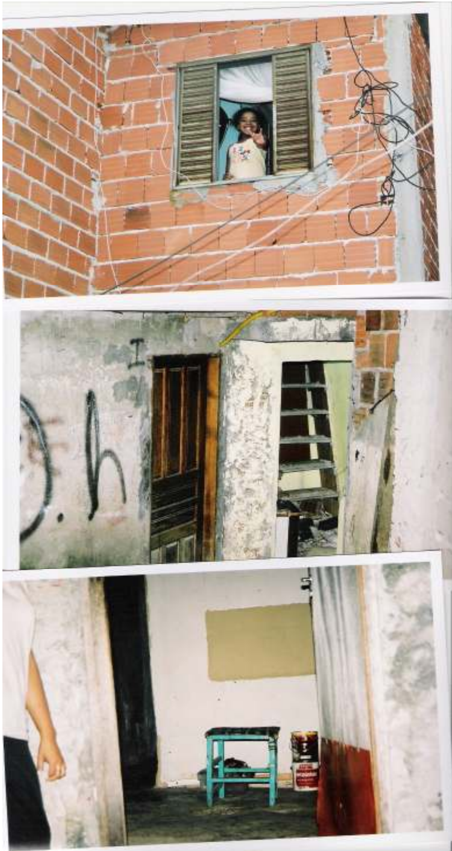
Fotos tiradas pelos moradores, em junho de 2005, durante a remoção: fachadas.
