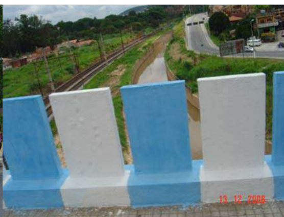
Foto-54-Vista sobre o viaduto da linha Férrea
