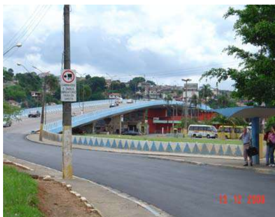
Foto-53– Viaduto no Centro de Franco de Rocha
