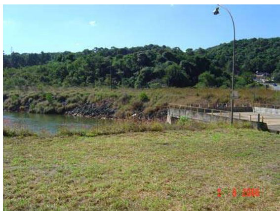
Foto-36 No limite da represa com a serra encontramos a Estação Elevatória de Santa Inês (foto ao lado), que bombeia a água para o reservatório de Águas Claras a um nível de 860m, localizado no alto da Serra da Cantareira e protegido pela Reserva Florestal da Cantareira.
