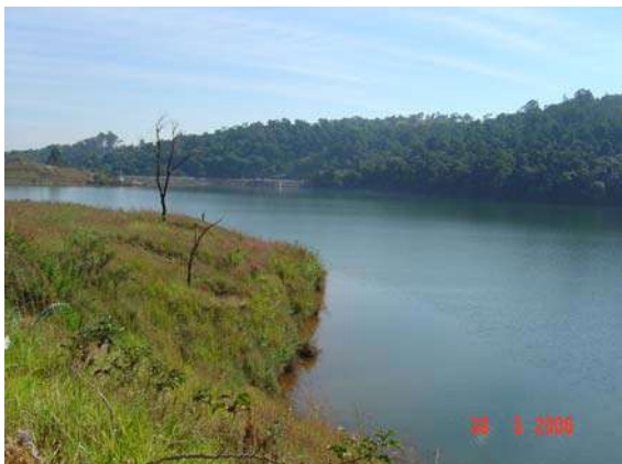
Reservatório Paulo de Paiva Castro a barragem ao fundo;
