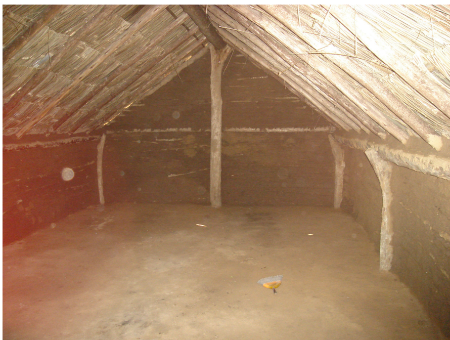
fig. 23. Interior da nova opy , Imaruí – SC.
