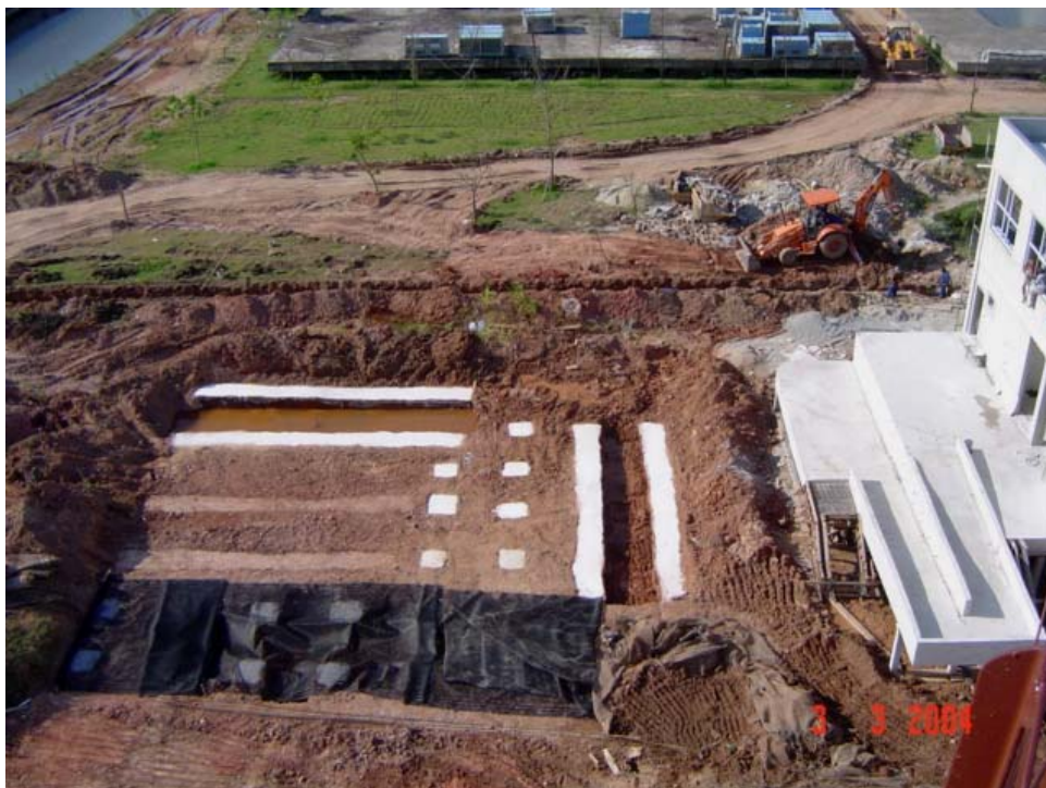
Figura 3.5- Vista geral da área experimental do aterro estaqueado reforçado do SESC/SENAC (SPOTTI, 2006).
