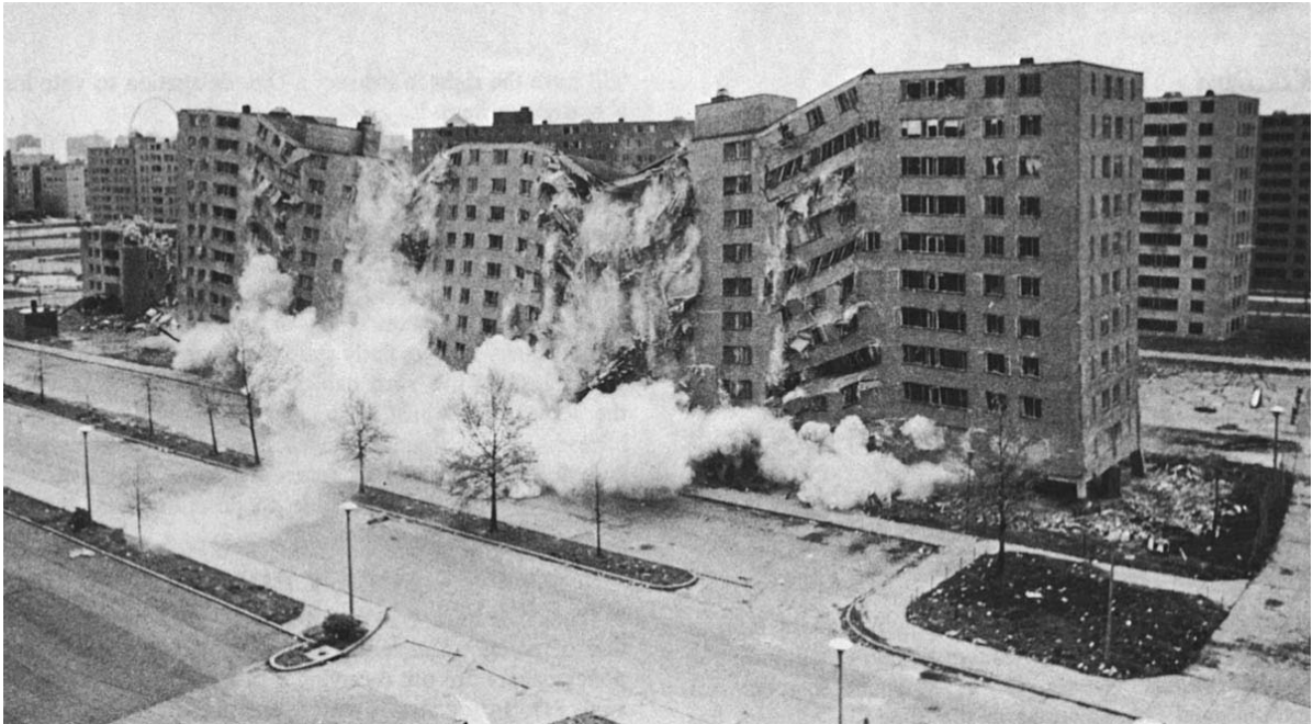
Demolição do conjunto habitacional Pruitt-Igoe, em Saint Louis, em 15 de julho de 1972. Imagem acessada de www.aliciapatterson.org/APF0801/Cohn/Cohn.html em 14 de abril de 2008.
