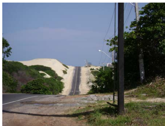
Figura 39: Acúmulo de areia na rodovia dificultando acesso ao Porto das Dunas. Fonte: Dados da pesquisa, 2008.
