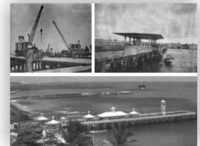
Fig. 111: Etapas das construções da Ponte dos Ingleses. Fonte: Arquivo Nirez.
