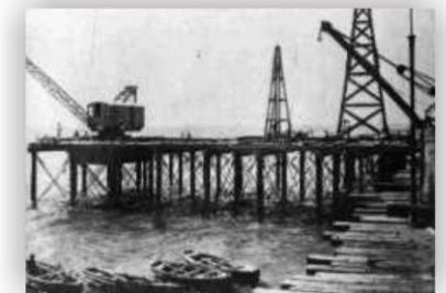
Fig. 85: Guindastes da Ponte Metálica. Fonte: Arquivo Nirez.
