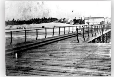
Fig. 83: Construção da Ponte Metálica. Fonte: Arquivo Nirez.
