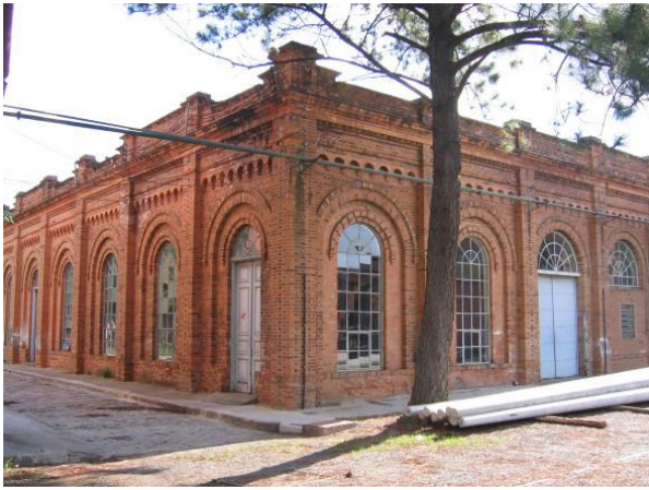
Na Fig. 33 , vista do edifício da usina geradora e na Fig. 34 , caixa d'água. Notar que não há base de cantaria no entorno dos prédios que, construídos em alvenaria de tijolos aparentes, assentam-se diretamente sobre base de concreto. Fotos da autora (2006).
