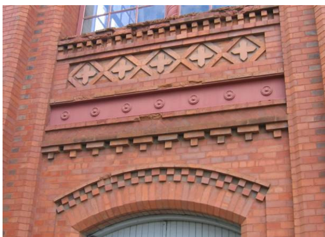
Na Fig. 52 e na Fig. 53 tem-se a ornamentação sobre as portas laterais da fachada principal. Excetuando-se a viga metálica executada com seção de trilho decorada, todos os outros ornatos foram rigorosamente executados com tijolos aparentes. Foto e desenho da autora (2006).
