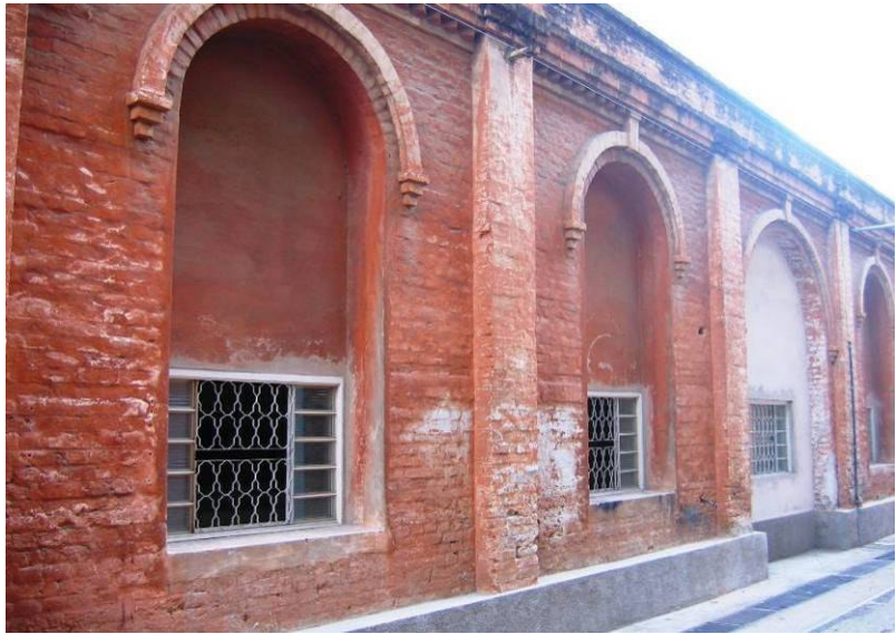
Na Fig. 100 , esquema do desenho original das janelas das laterais da seção de carros e vagões , elaborado a partir de foto desta face do edifício, pertencente ao acervo do Museu da Companhia Paulista. Na Fig. 101 , situação atual da fachada, na qual os vãos de janelas foram reduzidos a menos de um terço do original, e o vão de porta (à direita, na foto) foi igualmente fechado com alvenaria para instalação do mesmo tipo de vitrô. Foto e desenho da autora (2006).
