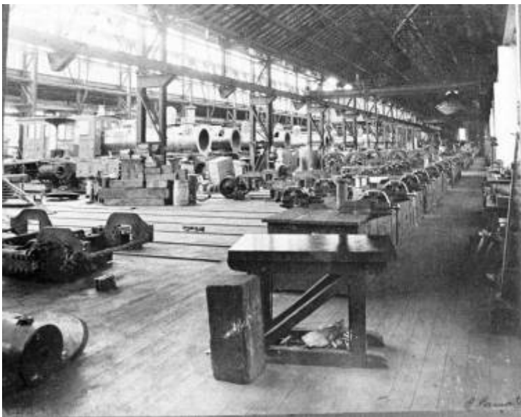
Na Fig. 80 vê-se plano geral da oficina de ajustagem . Notar à esquerda as locomotivas na oficina de montagem e, portanto, a permeabilidade e a integração dos diversos setores da seção de locomotivas . Acervo do Museu da Companhia Paulista.
