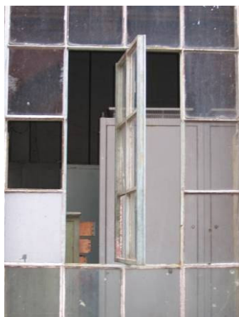
Modelo das janelas encontradas no edifício da usina geradora . Com verga em arco pleno, apresenta esquadrias e caixilhos metálicos e vedação de vidro transparente. Notar em destaque na Fig. 40 e na Fig. 41 a parte da janela com mecanismo de abertura pivotante. No geral, as aberturas se encontram em boas condições de conservação, excetuando-se os casos de vidros faltantes, como se vê na Fig. 42 . Desenho e fotos da autora (Fig. 40 e 42, 2006; Fig. 41, 2007).
