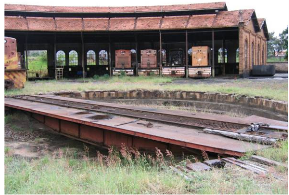
Na Fig. 136 , situação atual da rotunda das “Officinas Companhia Mogyana”, utilizada como depósito de máquinas desativadas e outros materiais não mais utilizados. À direita, na Fig. 137 , o girador, que com seus 15,05 metros de comprimento ocupa todo o centro da rotunda . Fotos da autora (Fig. 136, 2006; Fig. 137, 2007).
