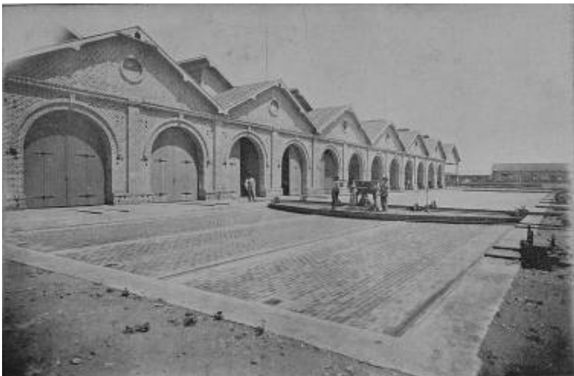
A Fig. 93 nos mostra vista externa dos galpões da seção de carros e vagões . RELATORIO nº. 52 da Directoria da Companhia Mogyana de Estradas de Ferro e Navegação para a Assembléa Geral de 25 de Junho de 1905, entre as páginas 188 e 189.
