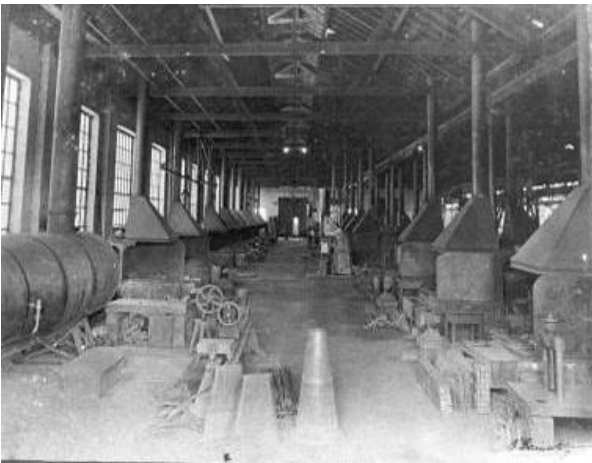
Vê-se na Fig. 91 , ao lado, plano geral da ferraria com o gerador de vapor da seção e na Fig. 92 funcionário da Mogiana trabalha na forja de uma peça. Acervo do Museu da Companhia Paulista.
