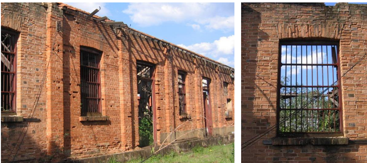
Na Fig. 123 , vê-se uma das poucas fachadas da fundição que ainda restam de pé. Executado com alvenaria de tijolos aparentes arranjados segundo aparelho inglês, o edifício era modulado pelas pilastras ressaltadas na alvenaria, entre as quais se davam os vãos de portas e janelas. Na Fig. 124 , detalhe do gradil de uma das janelas, executado em barras de ferro fundido. Fotos da autora (2006).
