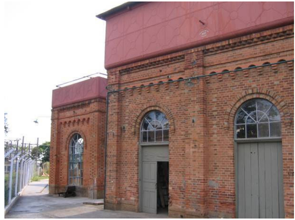
Na Fig. 33 , vista do edifício da usina geradora e na Fig. 34 , caixa d'água. Notar que não há base de cantaria no entorno dos prédios que, construídos em alvenaria de tijolos aparentes, assentam-se diretamente sobre base de concreto. Fotos da autora (2006).
