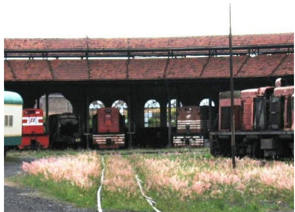
Na Fig. 143 , vista do lanternim a partir do interior da rotunda . Na Fig. 144 , em vista externa tomada a partir do girador, é possível perceber a permeabilidade da estrutura, que possui apenas as cobertas com telhas, mas as verticais completamente vazadas. Fotos da autora (2006).
