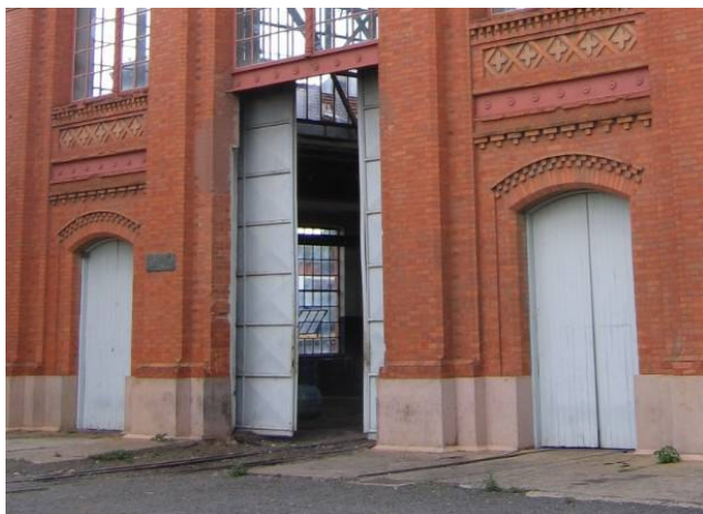
Na Fig. 51 apresenta-se o primeiro módulo de composição da fachada principal da seção de locomotivas . Ao centro, atentar para a porta principal, toda em estrutura e fechamento metálicos. Acesso das máquinas ao interior do edifício, motivo pelo qual é servida por trilhos de trem, possui as maiores dimensões dentre os vãos de portas existentes na oficina. Foto da autora (2006).
