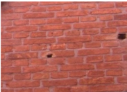
Na Fig. 102 , trecho da alvenaria da seção de carros e vagões em aparelho inglês, esquematizado na Fig. 103 . Foto e desenho da autora (2006).
