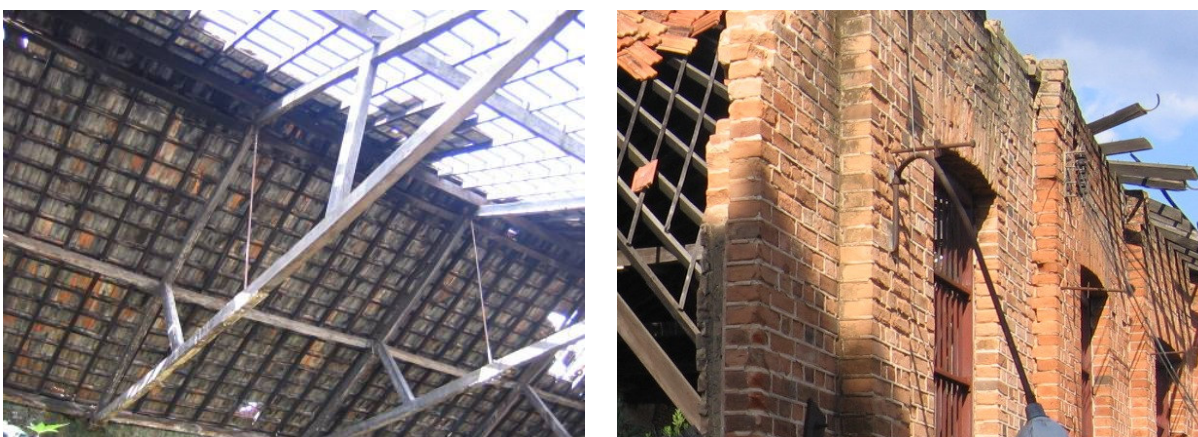
Situação atual da cobertura da fundição , executada com telhas francesas sobre estrutura de madeira. À esquerda, na Fig. 125 , vê-se a estrutura do telhado, com suas tesouras de madeira e pendurais metálicos. À direita, na Fig. 126 , notar que o madeiramento ultrapassa a fachada, evidenciando a existência de pequeno beiral. Fotos da autora (2006).
