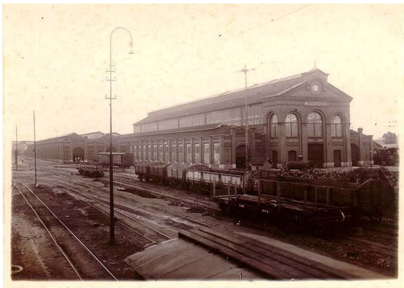
Vê-se na Fig. 48 , ao lado, vista geral do edifício da seção de locomotivas . O corpo central destacado abrigava a oficina de montagem das locomotivas. Os corpos laterais, por sua vez eram ocupados de um lado pela seção de tornos de rodas , e de outro pela caldeiraria e pela ferraria . Nos fundos da edificação situava-se a oficina mecânica . Acervo do Museu da Companhia Paulista.
