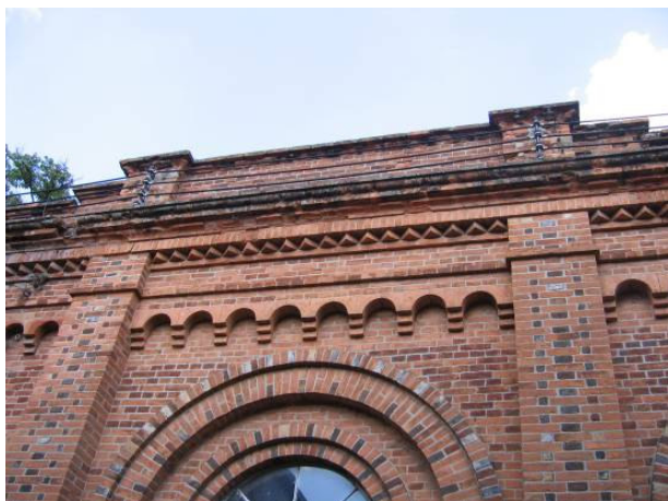
Na Fig. 38 , parte superior da usina geradora , arrematada com platibanda. Notar os elementos decorativos em tijolos aparentes: cornija e frisos variados. Notar também as pilastras, ressaltadas na alvenaria e executadas com aparelhamento ornamental, esquematizado na Fig. 39 , com tijolos em tons de laranja e cinza. Foto e desenho da autora (2006).
