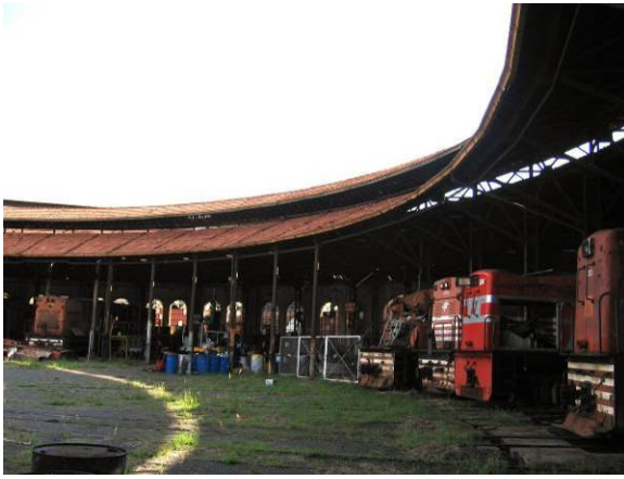
Na Fig. 136 , situação atual da rotunda das “Officinas Companhia Mogyana”, utilizada como depósito de máquinas desativadas e outros materiais não mais utilizados. À direita, na Fig. 137 , o girador, que com seus 15,05 metros de comprimento ocupa todo o centro da rotunda . Fotos da autora (Fig. 136, 2006; Fig. 137, 2007).
