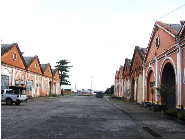
Na Fig. 94 pode-se observar a situação da seção de construção e reparação de carros e vagões , após a ampliação. À direita, vemos a seqüência dos seis galpões inicialmente construídos e, à esquerda, a ampliação, com edificações idênticas às primeiras. Foto da autora (2006).
