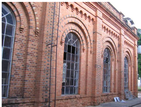
Modelo das janelas encontradas no edifício da usina geradora . Com verga em arco pleno, apresenta esquadrias e caixilhos metálicos e vedação de vidro transparente. Notar em destaque na Fig. 40 e na Fig. 41 a parte da janela com mecanismo de abertura pivotante. No geral, as aberturas se encontram em boas condições de conservação, excetuando-se os casos de vidros faltantes, como se vê na Fig. 42 . Desenho e fotos da autora (Fig. 40 e 42, 2006; Fig. 41, 2007).
