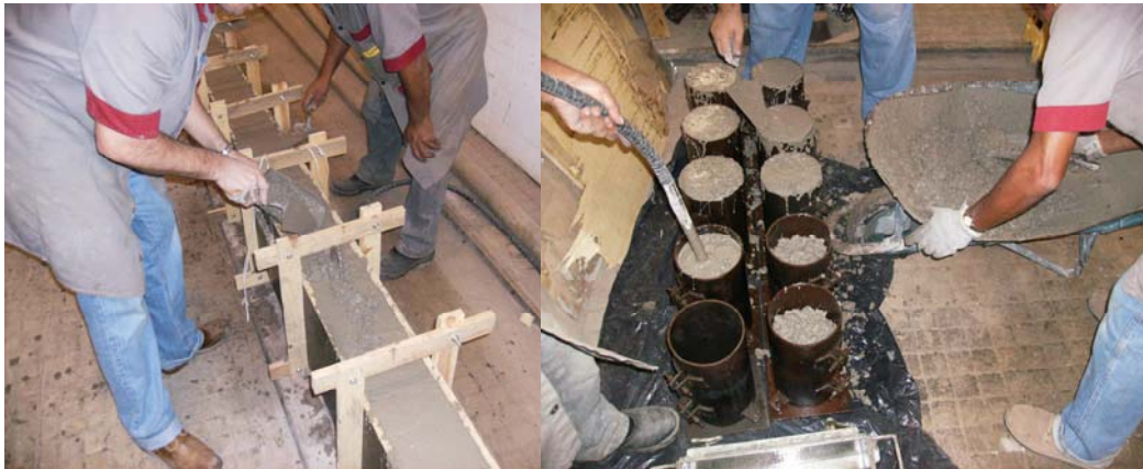
Figura 3.7 - Lançamento e adensamento do concreto.
