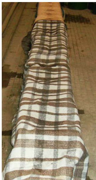
Figura 3.8 - Cura das vigas com mantas umedecidas.
