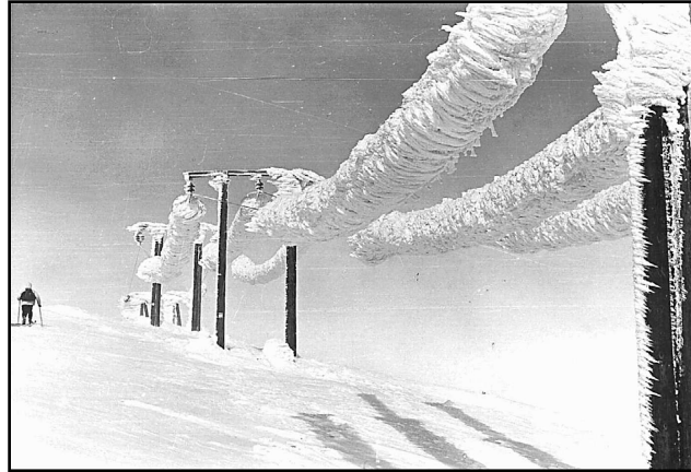
Figura 2.1: Formação de gelo em linha de 22kV em Voss, Noruega (MAKKONEN, 2000)
