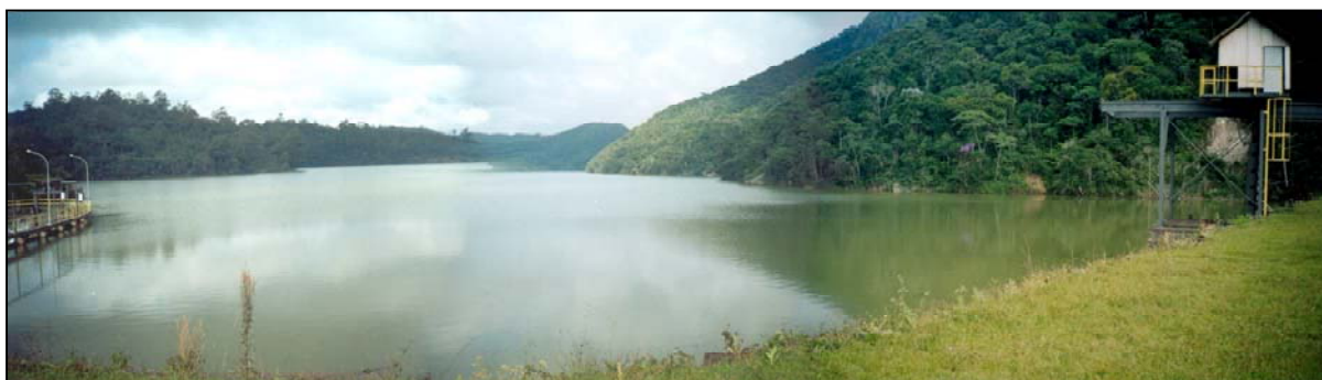
Figura 1.2 – Vista parcial da Barragem do Ribeirão da Cachoeira em março/2003 (verão).
