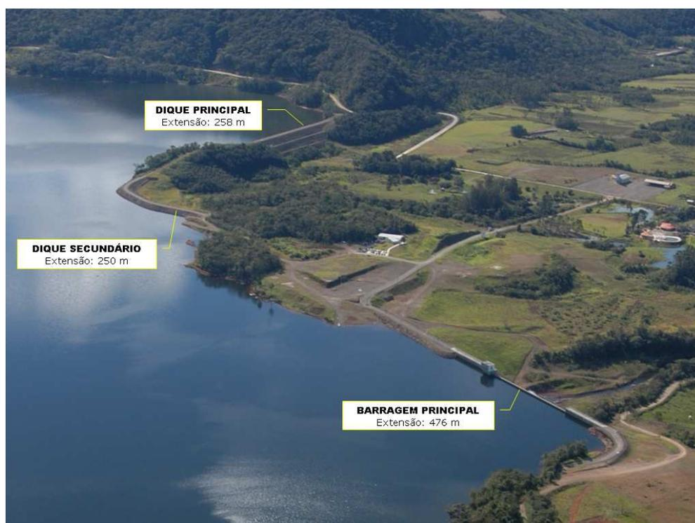
Figura 11. Estruturas de contenção das águas do reservatório. Fonte: CASAN, 2006.
