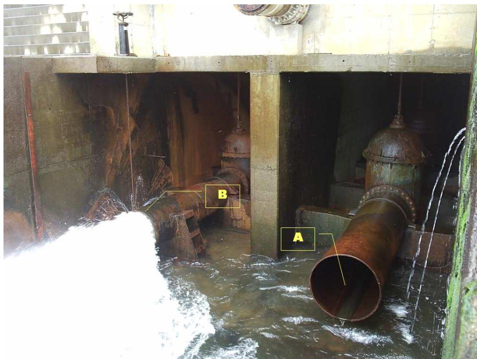
Figura 17. Descarregadores de fundo de 1000 (A) e 800 mm (B). Fonte: CASAN, 2006.
