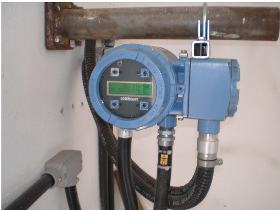
Figura 22. Macromedidor de vazões da adutora da barragem do rio São Bento.
