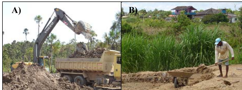
Figura 5.3 – Extração da matéria-prima: (A) com retroscavadeira e (B) manualmente com auxílio de pá.
