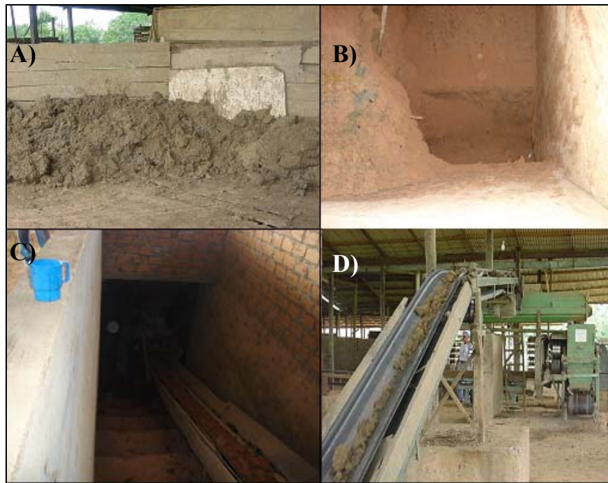
Figura 5.5 – Equipamentos das olarias: (A) Caixa alimentador; (B) Caixa alimentador; (C) Laminador; (D) Esteira.
