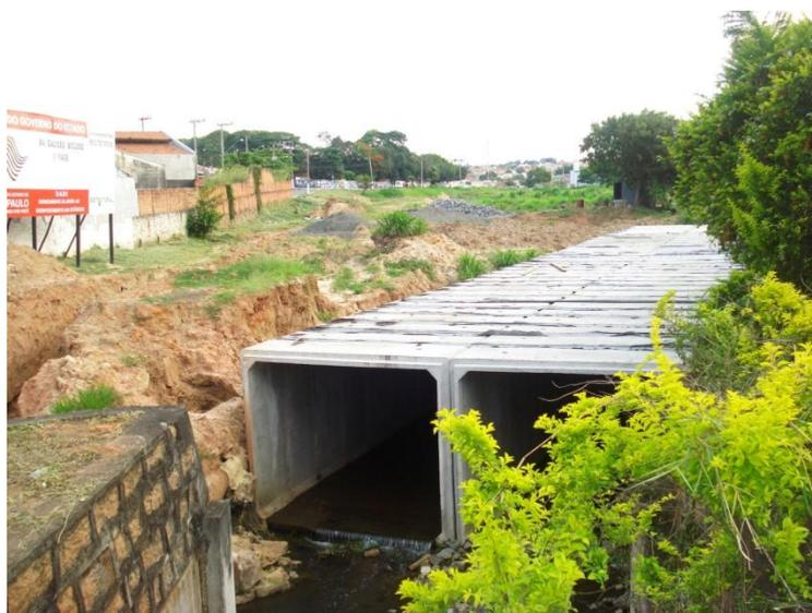
**Figura 10:** Obra de canalização de trecho do ribeirão Brochado. À esquerda, o Centro. À direita, o Jd. Santana.
