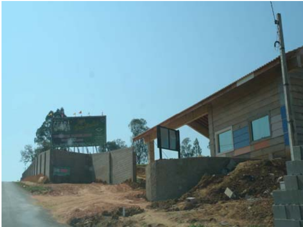
fig 76 : Condomínios em construção
