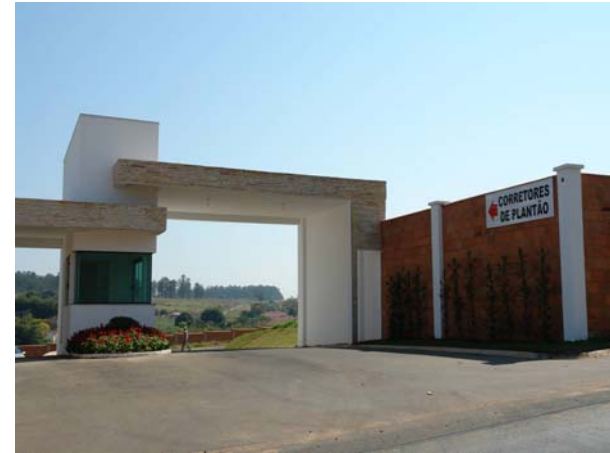
fig 78 : Condomínios em construção
