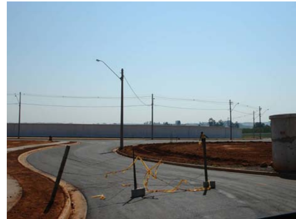
fig 79 : Condomínios em construção
