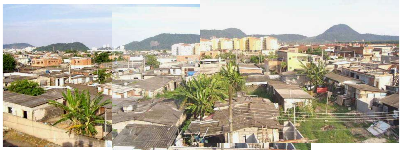
Fig. 102 – Vista do Setor 1 de Urbanização – Favela México 70, São Vicente, SP (CDHU, 2007)
