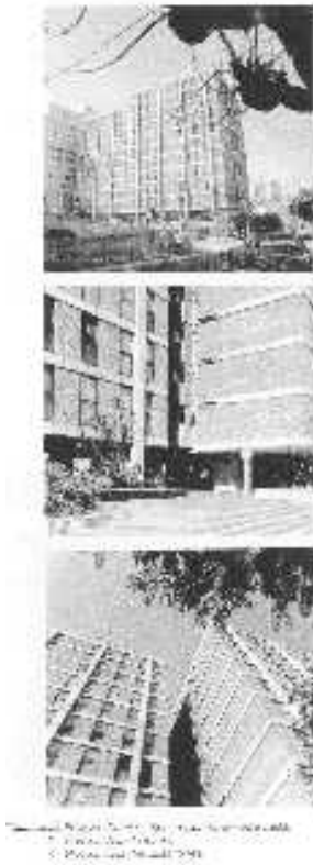
Fig. 40 – Edifício de apartamentos Gemini (1969) – Eduardo de Almeida (IMBROLITO, 2004).
