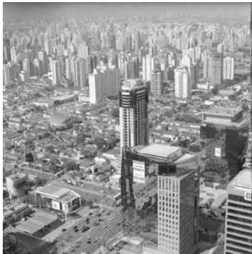
Fig. 47 – Região da avenida Berrini – processo atual de verticalização e expansão de serviços (MEYER, 2004).
