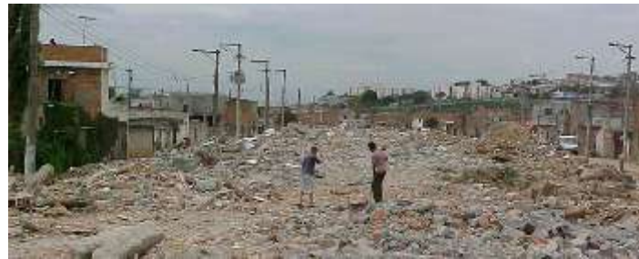
Fig. 81 – Projeto Pantanal - demolição da área do Parque Central (CDHU, 2004)
