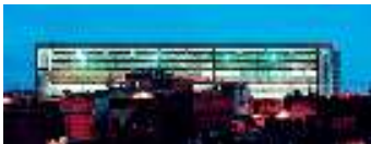
Fig. 77 – Escola da Fundação para o Desenvolvimento da Educação (FDE) implantada na área do Projeto Pantanal em 2005 (ProjetoDesign, n. 314, abr. 2006).
