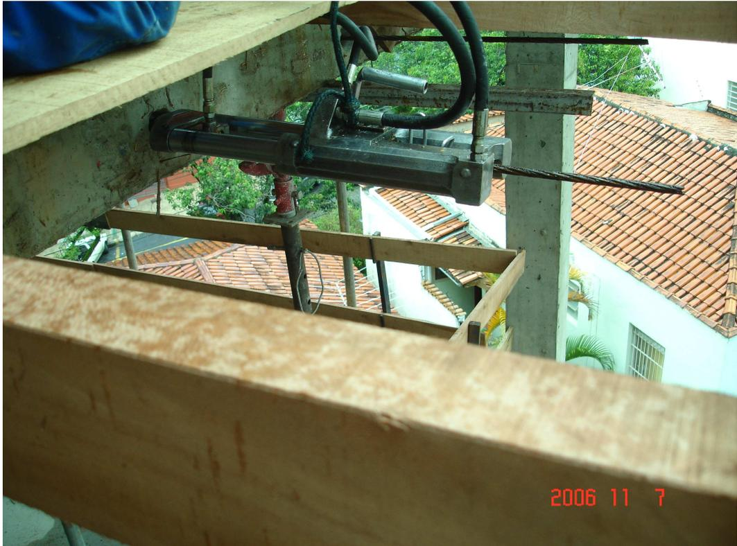
**Figura 2.9** – Detalhe do atuador hidráulico para protensão
