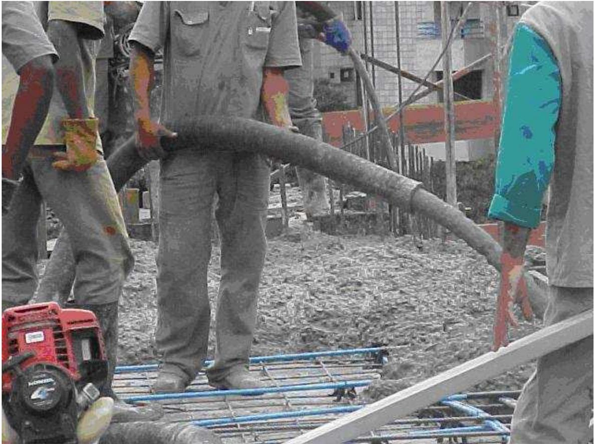
**Figura 1.7 – Lançamento do Concreto**
