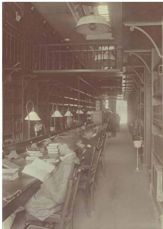
Interior do Prédio da Rua Passeio, 1858
