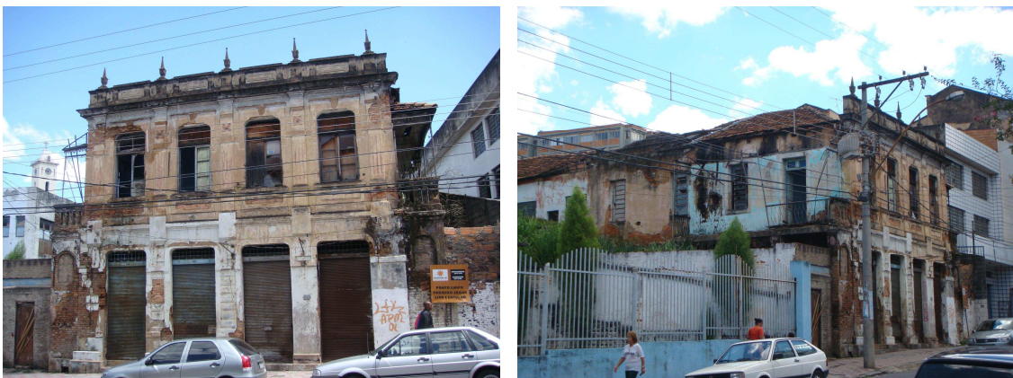
Figura 15: Edificação tombada Rua Itapecerica, 373 – vista de frente e lateral Fonte: Acervo da autora
