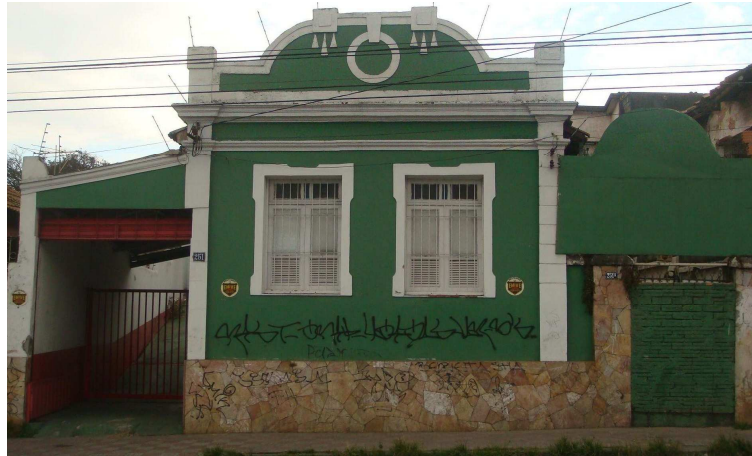
Figura 16: Edificação tombada – Rua Itapecerica, 251 Fonte: Acervo da autora
