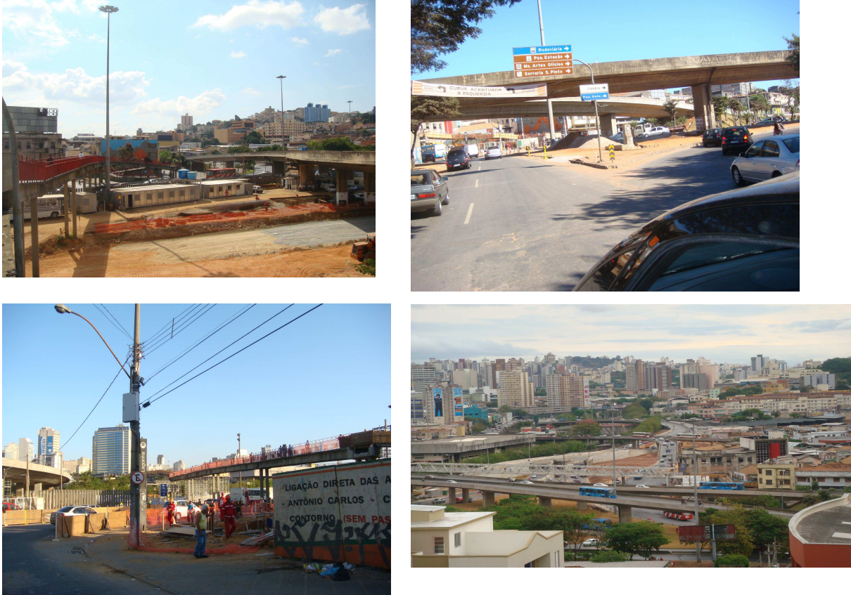
Figura 02: Vista do complexo da Lagoinha – início das obras e concluída em outubro de 2008
