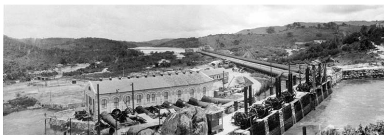
Figura 18 – Usina Edgard de Souza. De estrutura de geração de energia, no início do século XX, passou para estrutura de regularização de vazão, após os anos 1950. Fonte: Solia, Faria e Araújo (2007).
