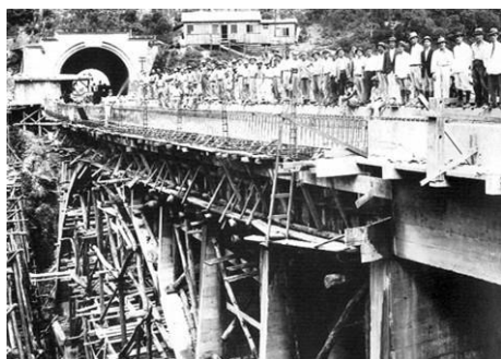
Figura 40 – Construção da linha Mairinque-Santos. Com esta iniciativa, parte do transporte de cargas deixava de atravessar o espaço intra-urbano da cidade. Fonte: Soukef Junior (2001).
