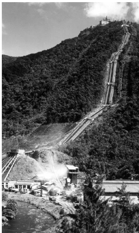
Figura 19 – Usina Henry Borden. Detalhe para o desnível de 720 metros entre o planalto e a Baixada Santista, utilizado para a geração de energia. Fonte: Solia, Faria e Araújo (2007).
