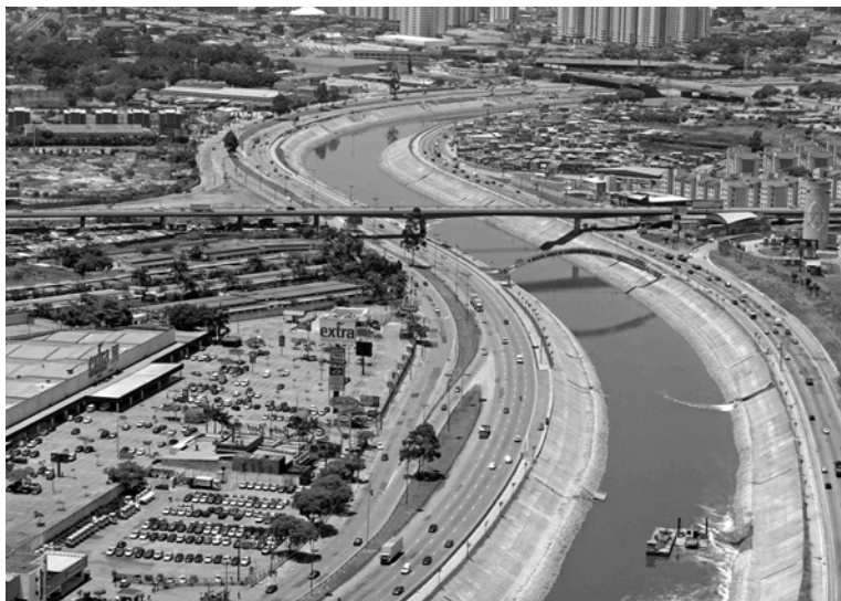
Figura 25 - Calha do rio Tietê ampliada. A obra consolidou o trecho urbano do rio como uma grande estrutura hidráulica anexa ao sistema de vias expressas. Fonte: DAEE (2006).
