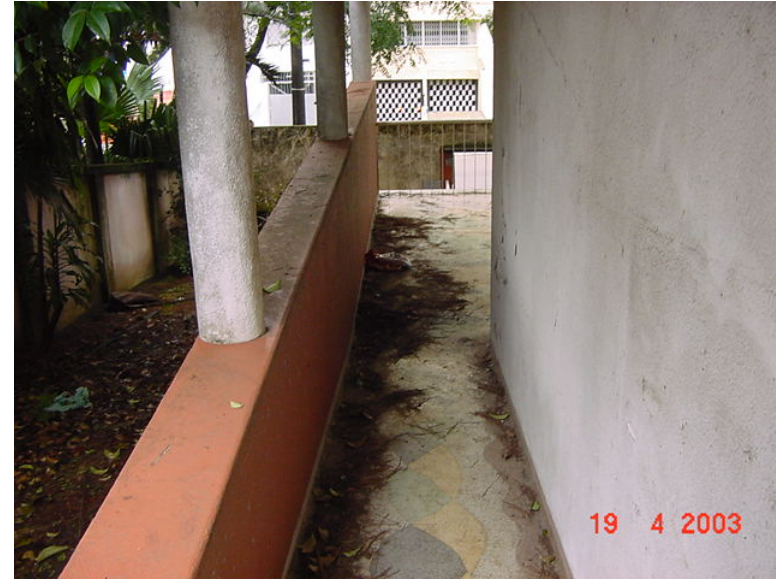
Rampa de acesso à varanda
