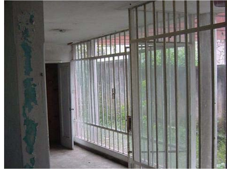
Esquadrias do hall de entrada
