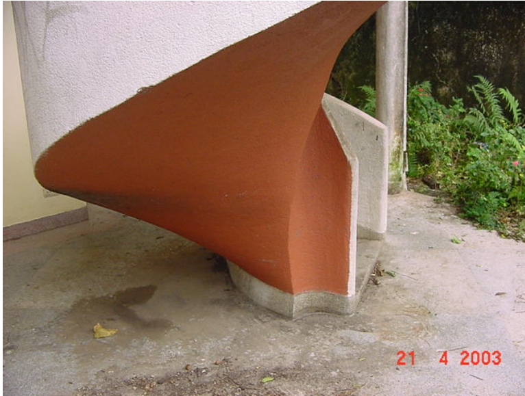
Piso dos fundos
