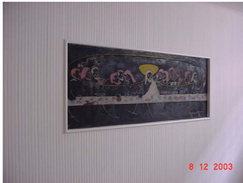
Figura 96 – Parede da copa com revestimento em lambri
