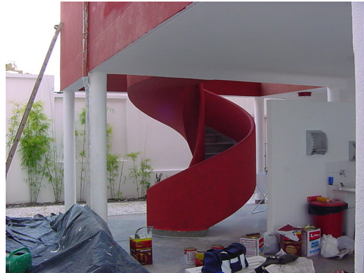
Pintura da escada caracol
