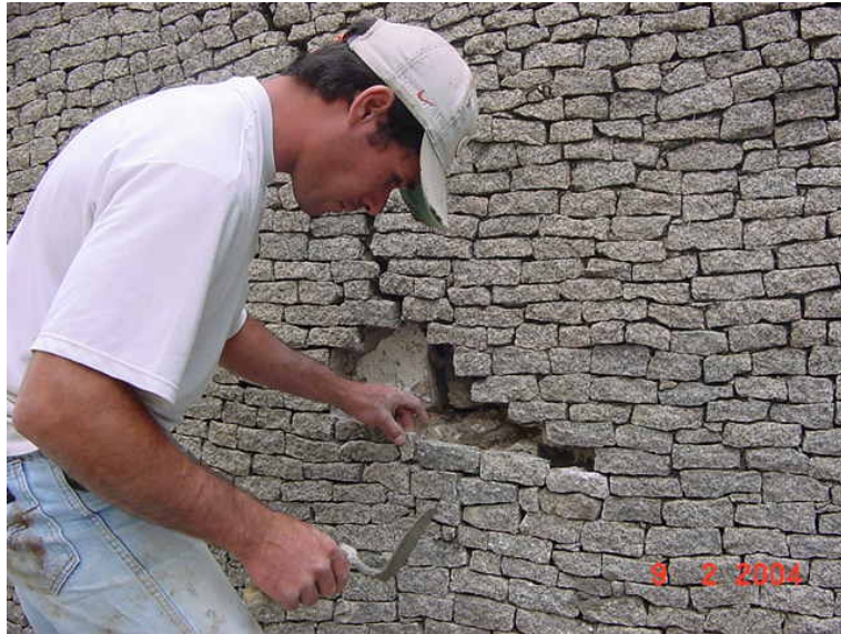
Recuperação do muro frontal
