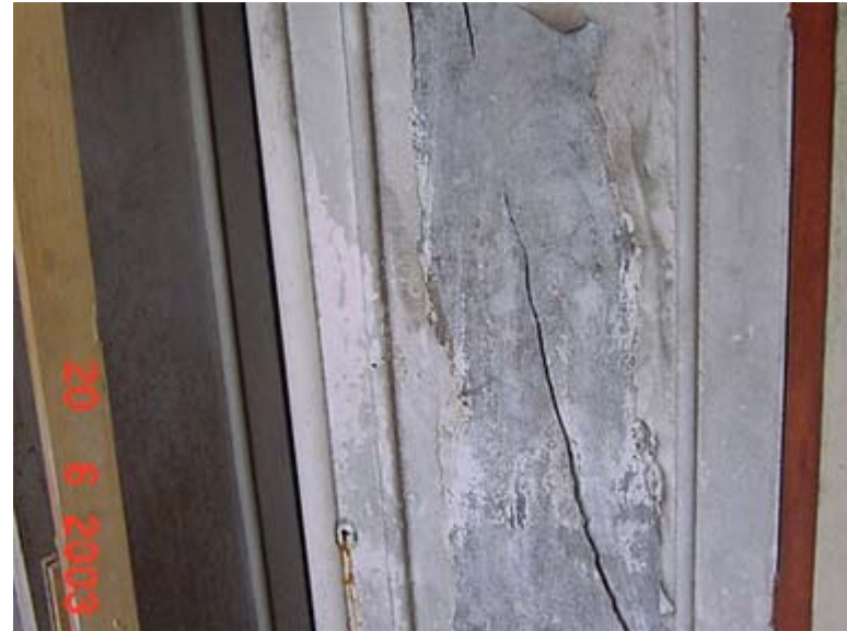
Porta do armário da área de serviço
