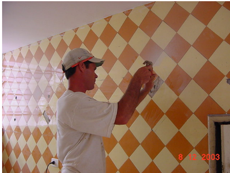
Recuperação do revestimento da cozinha
