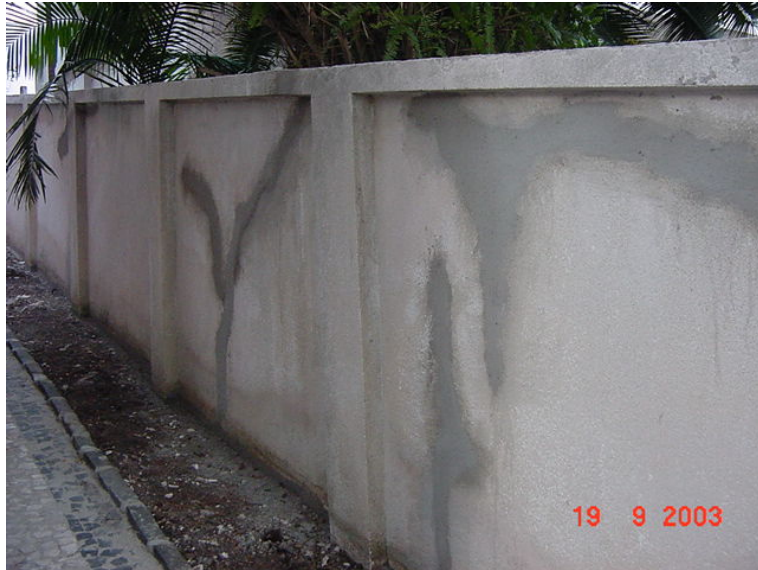
Recuperação do muro lateral
