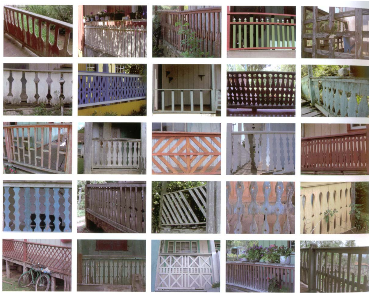
Figura 12 – Exemplos de Guarda-corpos das varandas
