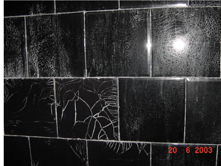
Revestimento cerâmico (20x20cm) do banheiro do quarto do casal
