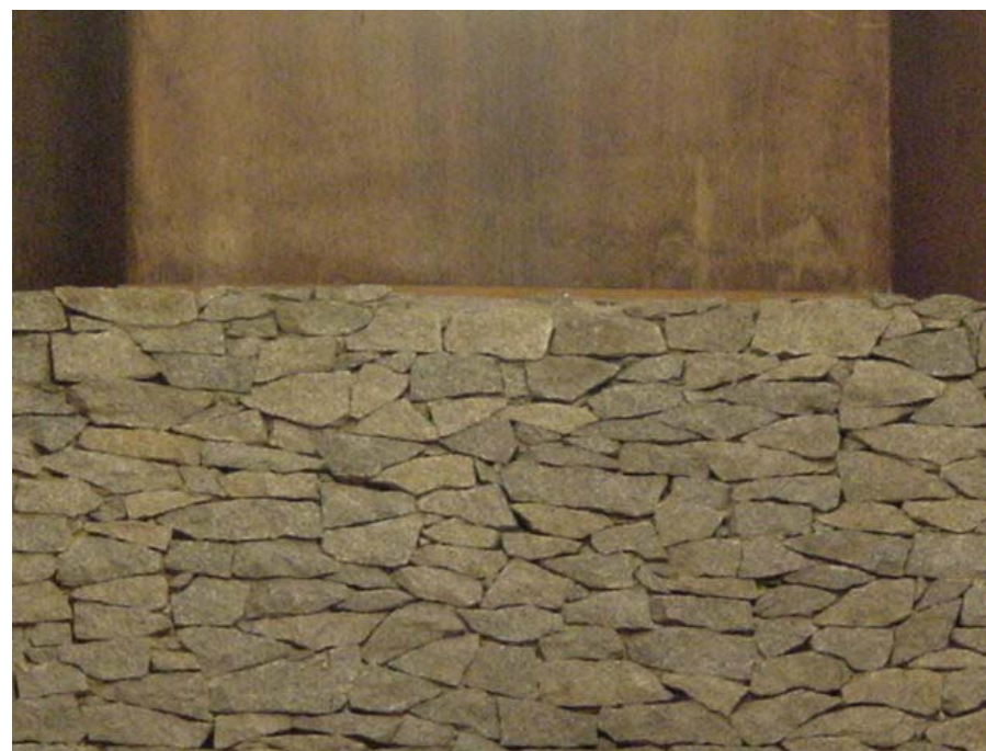
Figura 99 – Detalhe do revestimento da lareira
