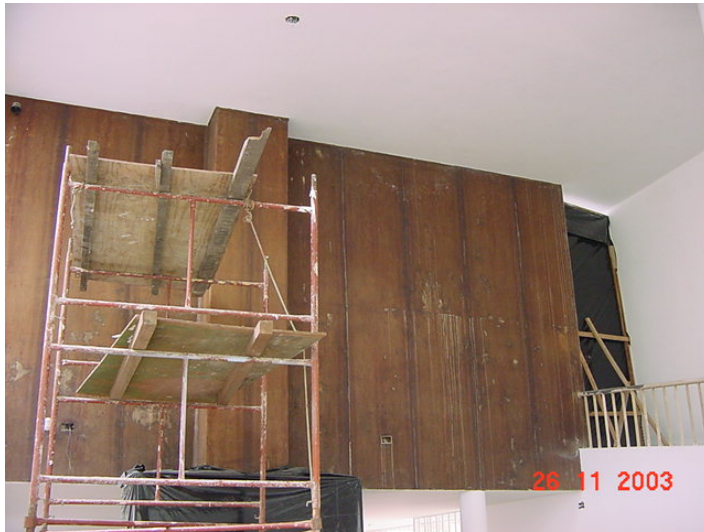
Recuperação do painel da sala da lareira
