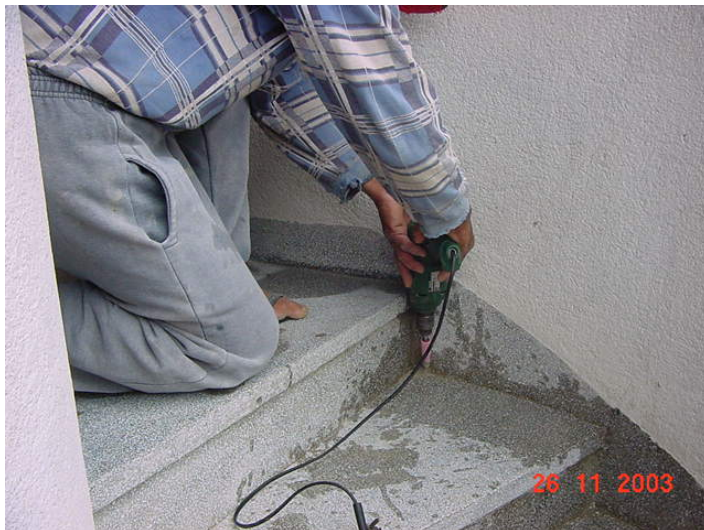
Restauração do revestimento cerâmico da cozinha e da granitina da escada caracol
