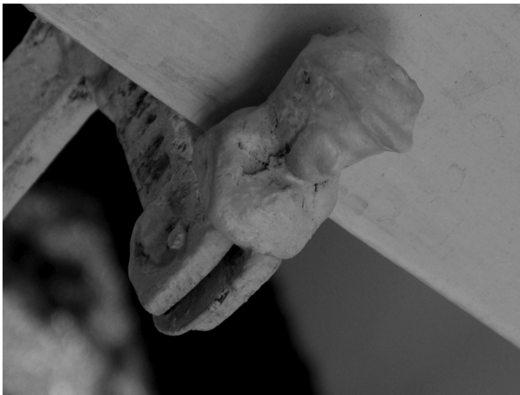
Figura 48 – Foto de detalhe da Casa Bettega
