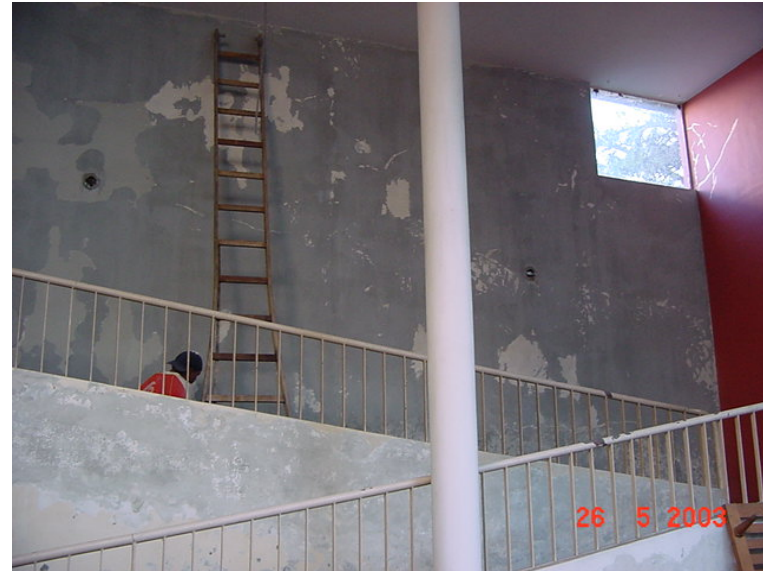
Lixamento e pintura das paredes internas
