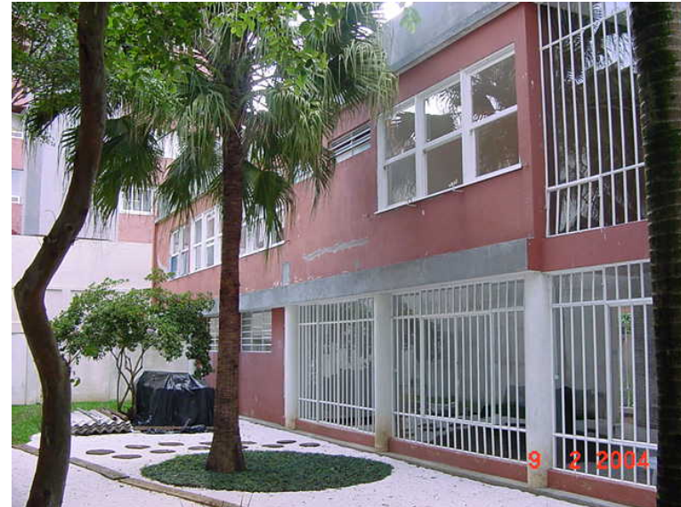
Pintura da fachada externa
