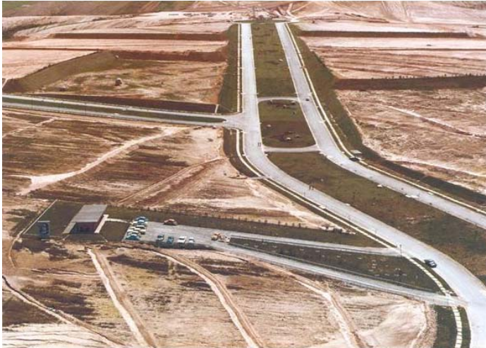
FIGURA 2.01 – Construção da Av. Rio Negro, 1974. Crédito: WILLER, Marcelo. Uma Edge City Brasileira: O Exemplo de Alphaville. Seminário Transporte Interurbano de Passageiros. São Paulo, 2006
