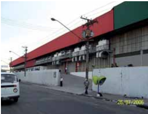
Fig. II.26: Foto da Rua Cel. Marques Ribeiro: Portão de acesso às docas do pavilhão vermelho. Essa mesma solução se repetirá nas demais ruas contíguas ao lote. Fonte: Acervo do autor deste trabalho.
