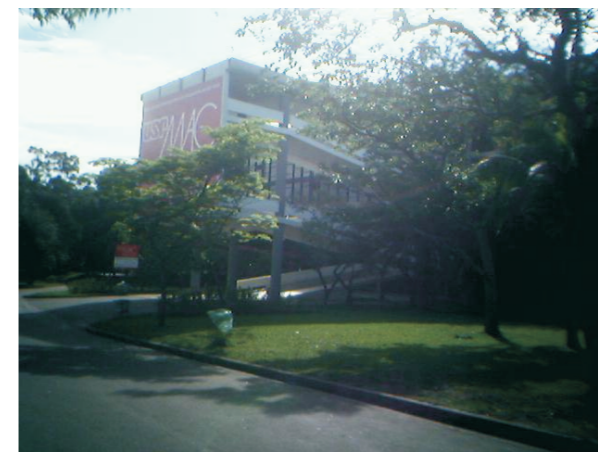
3- Foto da rampa de acesso ao 3o. Andar do Pavilhão Ciccillo Matarazzo. Fonte: Acervo do autor deste trabalho.
