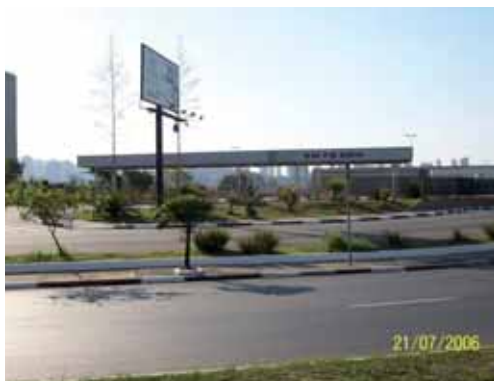
Fig. II.52: Foto da cobertura dos portões automáticos de acesso ao estacionamento pago. Usa o mesmo sistema eletrônico usado na maioria dos estacionamentos de shopping centers da cidade. Fonte: Acervo do autor deste trabalho.
