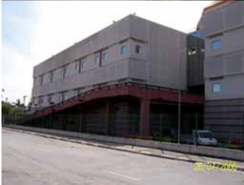
Fig. II.44: Foto da Rua Padre Emílio Miotti: Rampa para carga e descarga com acesso ao primeiro piso de exposições. Também construída para minimizar problemas com o acesso de cargas aos locais de exposição. Fonte: Acervo do autor deste trabalho.
