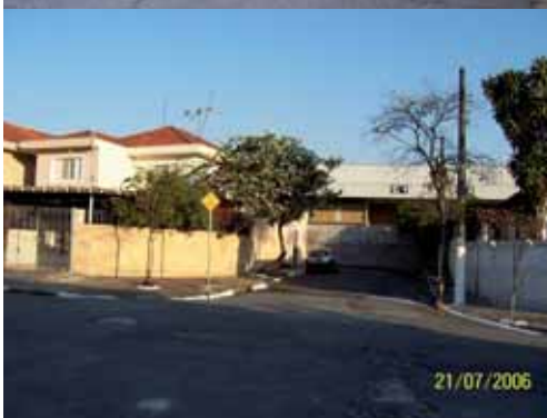
Fig. II.60: Foto da esquina da Rua Tertuliano Branco vista a partir da Rua José G. Sobrinho, com casas entre o acesso bloqueado ao terreno do pavilhão, na área de docas. No lugar do portão, foi construído um muro de alvenaria. Possível sinal de problemas com o trânsito de caminhões no passado. Fonte: Acervo do autor deste trabalho.
