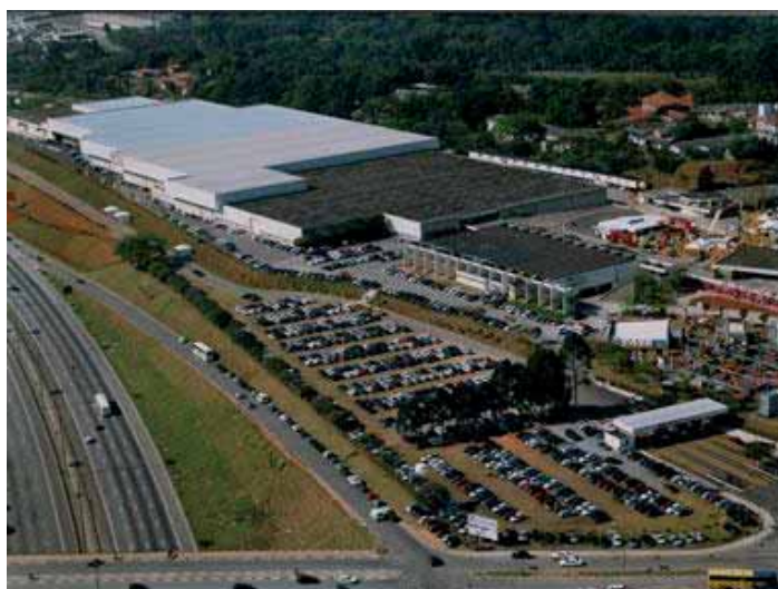
Fig. III.24: Vista aérea do Centro de Exposições Imigrantes a partir de sua entrada e pátio de estacionamento. Fonte: www.centroimigrantes.com.br .
