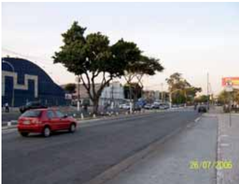
Fig. II.15: Foto da Entrada principal do Centro: pavilhão oeste recente, com elemento marcante na arquitetura do pavilhão, funcionando como ponto focal e torre sinalizadora. Fonte: Acervo do autor deste trabalho.
