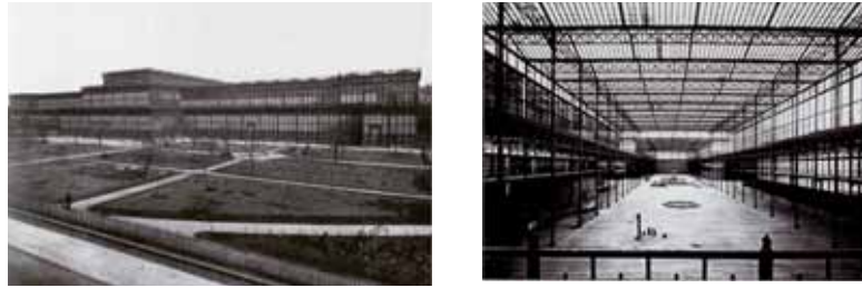
Fig. I.26 e I.27: Pavilhão para Exposição Industrial de Munich, Alemanha, 1853-1854 (GÖSSEL e LEUTHÄUSER:2005).
