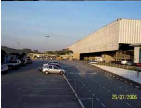
Fig. II.10: Foto da via de circulação interna e acesso aos guichês do estacionamento para visitantes: várias pistas e vários pontos de atendimento no acesso de veículos. Implantação típica dos pedágios em rodovias. Em momentos de pico, o atendimento manual gera acúmulo de veículos que se estende até a Av. Olavo Fontoura. Fonte: Acervo do autor deste trabalho.
