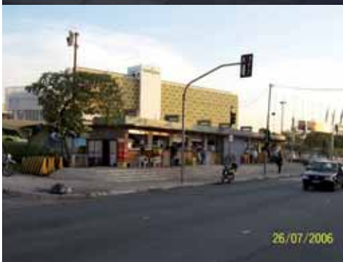
Fig. II.16: Foto do comércio instalado em lanchonetes padronizadas: estrutura de apoio aos profissionais envolvidos na montagem dos eventos e com acesso também para a Avenida Olavo Fontoura. Fonte: Acervo do autor deste trabalho.
