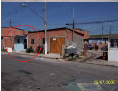
Fig. II.45: Foto da Rua Padre Emílio Motti: Casas típicas localizadas enfrente ao Centro. É interessante notar a presença de pequenos restaurantes para atender aos profissionais envolvidos na montagem dos eventos. Fonte: Acervo do autor deste trabalho.
