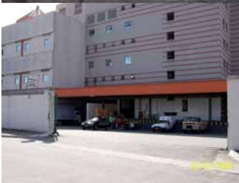
Fig. II.46: Foto da Rua Padre Emílio Motti: Portão de acesso às docas existentes desde a construção do edifício. Fonte: Acervo do autor deste trabalho.
