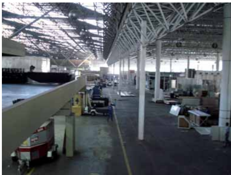
Fig.III.8: Vista da interligação entre os pavilhões norte-sul (à esquerda na foto) e oeste (à direita na foto). Fonte: Foto tirada em 10/10/2006 pelo autor deste trabalho, durante a montagem do Salão do Automóvel.
