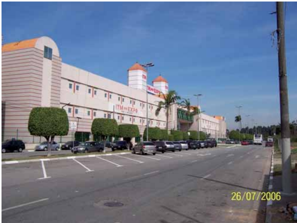
Fig. III.22: Foto do local: Fachada frontal do ITM Expo com estacionamento à frente, na Avenida Engenheiro Roberto Zucollo. Fonte: Acervo do autor deste trabalho.
