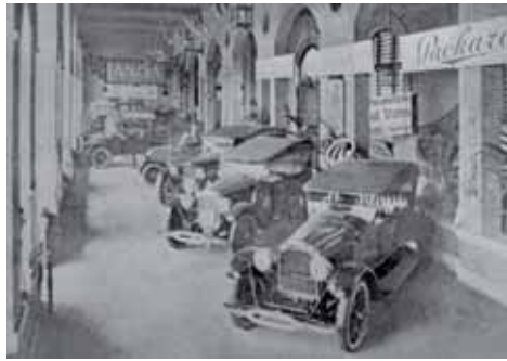
Fig. I.51 - Galeria ocupada por veículos na I Exposição de Automobilismo e Rodoviação, 1923. (Fonte: www.carroantigo.com em 15/02/2009 às 17:57).
