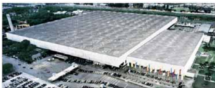
Fig.III.6: Vista aérea do Pavilhão de Exposições do Anhembi a partir da entrada do conjunto composto pelo pavilhão oeste (menor, à direita) e o pavilhão norte-sul (maior, à esquerda).
