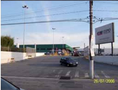
Fig. II.27: Foto da entrada principal do pavilhão verde, na Rua Cel. Marques Ribeiro: portão recuado em relação a via local, minimiza congestionamentos quando há fila de veículos para entrar no local. Fonte: Acervo do autor deste trabalho.
