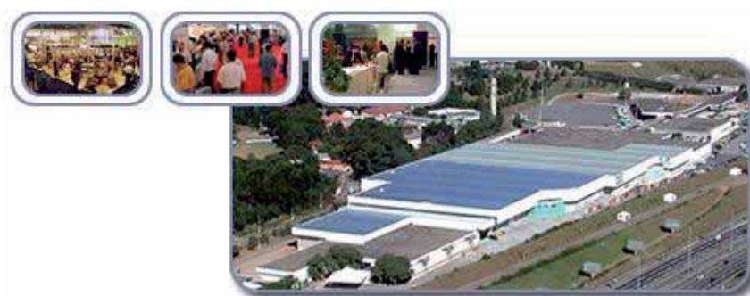
Fig. III.23: Vista aérea do Centro de Exposições Imigrantes na foto maior e fotos de eventos em detalhe, nas fotos menores. Fonte: www.centroimigrantes.com.br .
