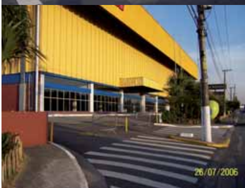
Fig. II.30: Foto da entrada principal do pavilhão amarelo: O único não integrado aos demais e o único pavilhão com acesso direto para a via local. Entrada do estacionamento à esquerda e direita do edifício. Fonte: Acervo do autor deste trabalho.
